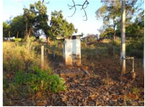
Foto 2 - Área do poço sem cerca
