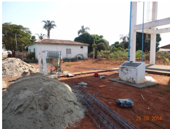
Foto 1 – Cerca sendo substituída por muro de alvenaria
