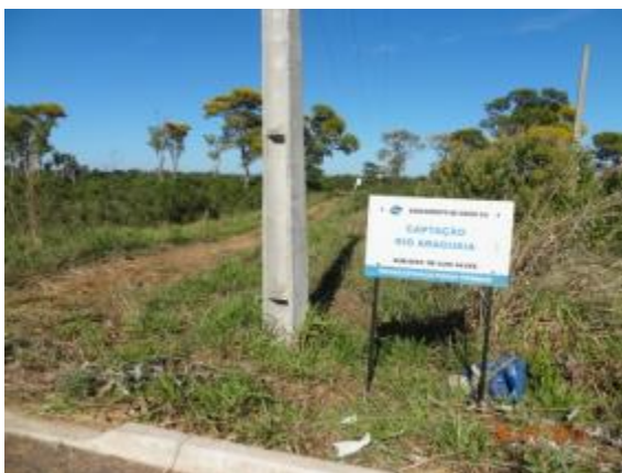
Foto 1 - Local sem cerca de proteção
