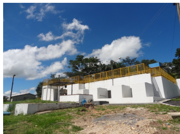
Foto 2 – Guarda corpo instalado.
