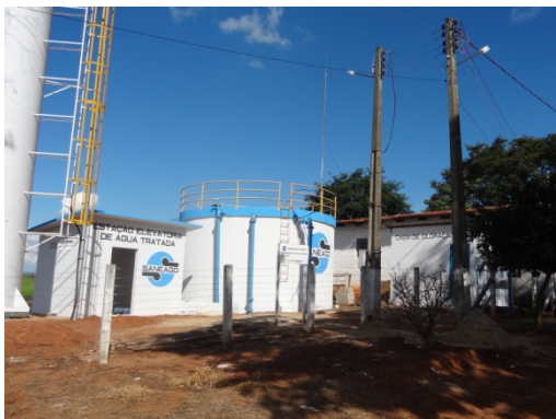
Foto 03 – Reservatório Seme-enterrado com pintura nova
