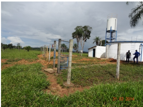
Foto 3- Cerca reparada no R2
