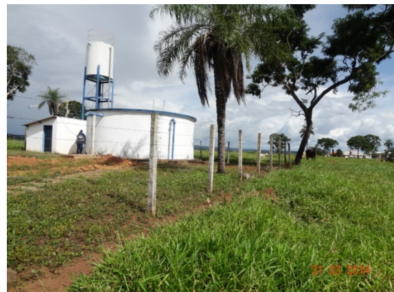
Foto 4- Cerca reparada no R3
