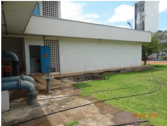
Foto 01 – ETA – Revestimento recuperado.
