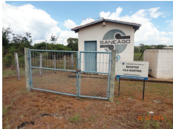
Foto 02 – Portão recuperado – EEAT Vila Martins
