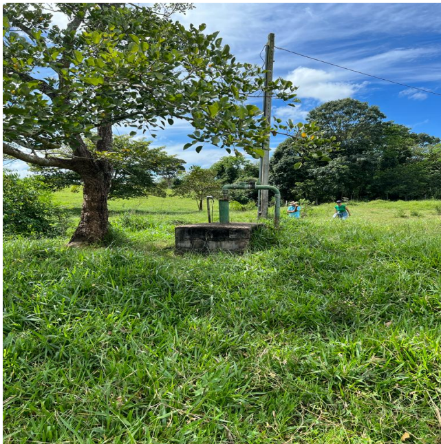
Foto 5 - Poço P3 sem cerca de proteção.
