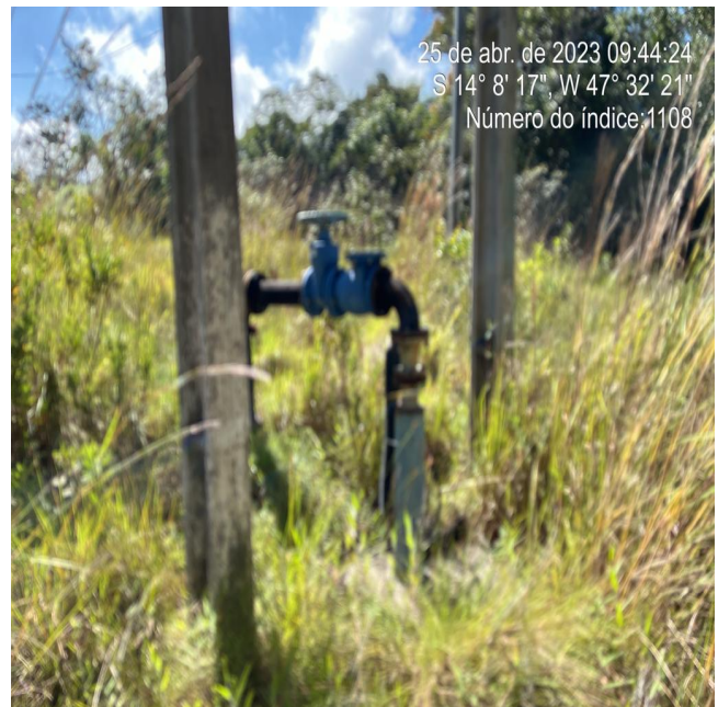
Foto 8 - Poço 01 sem urbanização.
