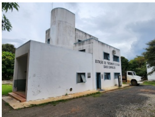
Foto 3 - Estação de Tratamento de Água - ETA
