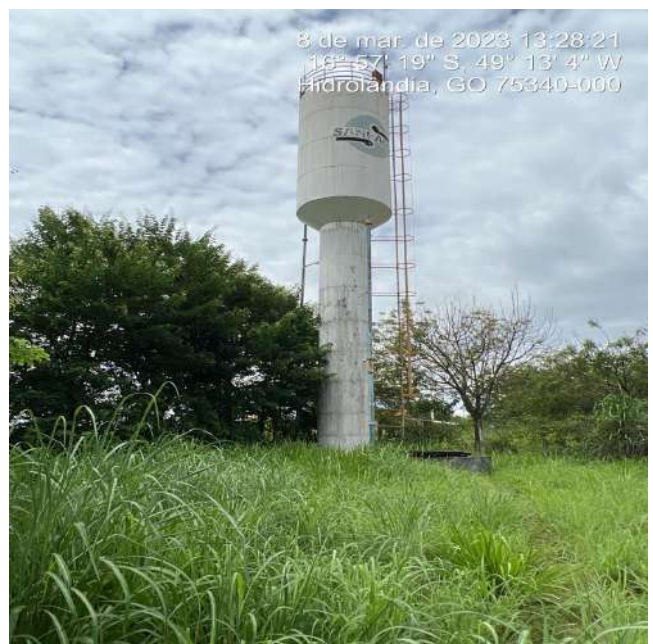
Foto 12 - REL metálico sem acesso para manutenção - Área invadida por terceiros.
