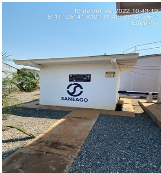
Foto 6 - EEAT com edificação recuperada.
