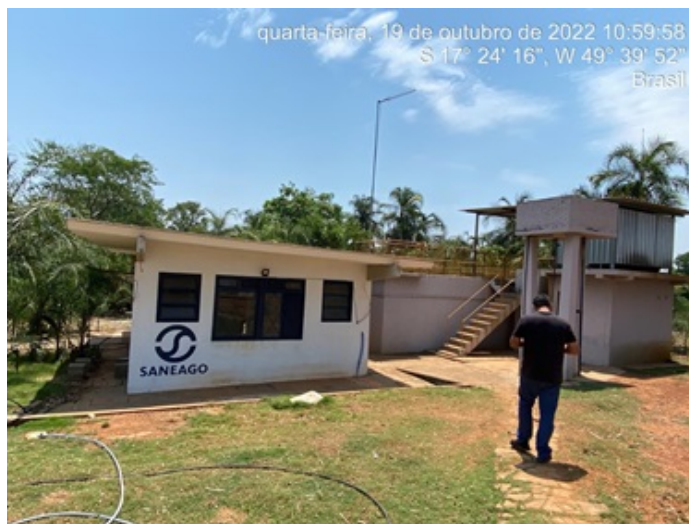
Foto 2 - ETA com edificações recuperadas.
