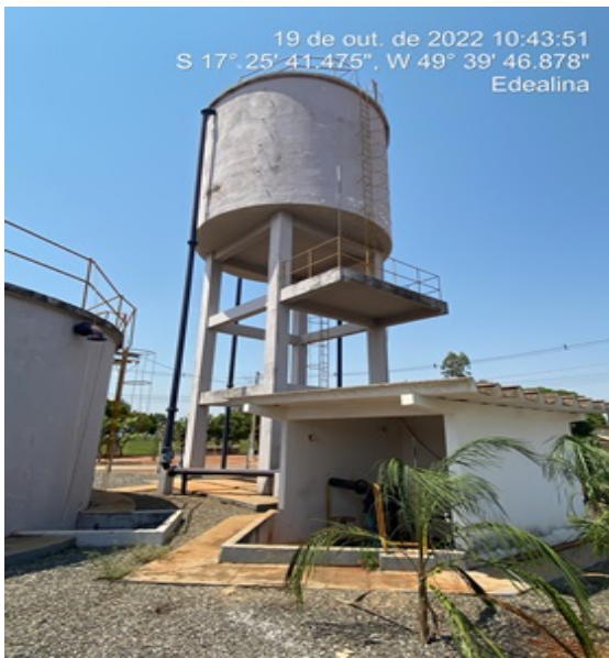
Foto 7 - EEAT com edificação recuperada.
