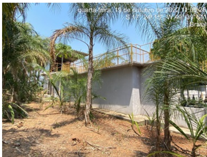
Foto 4 - ETA com pinturas dos floculadores recuperados e guarda corpos instalados.
