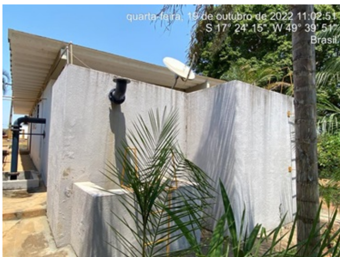
Foto 3 - ETA com floculadores recuperados.
