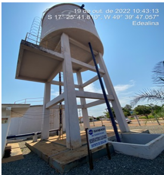
Foto 5 - REL do CR Alto Paraíso com pintura recuperada.
