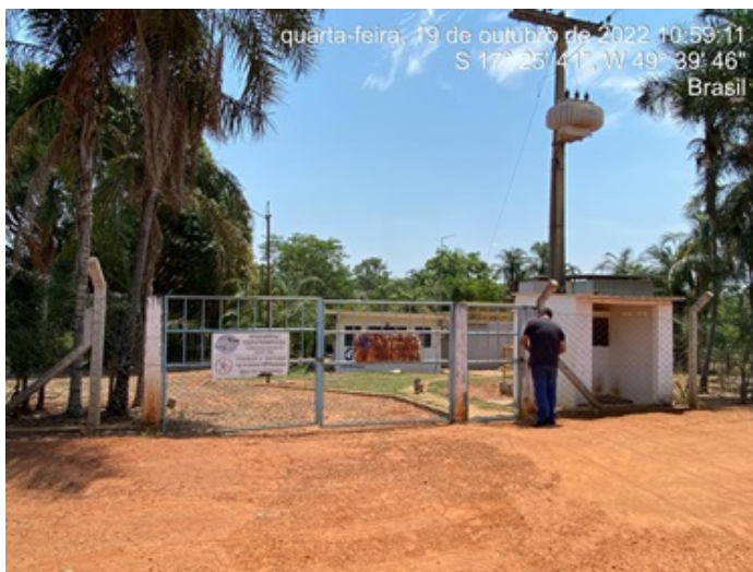
Foto 1 - ETA com cerca de proteção da área urbanizada recuperada.
