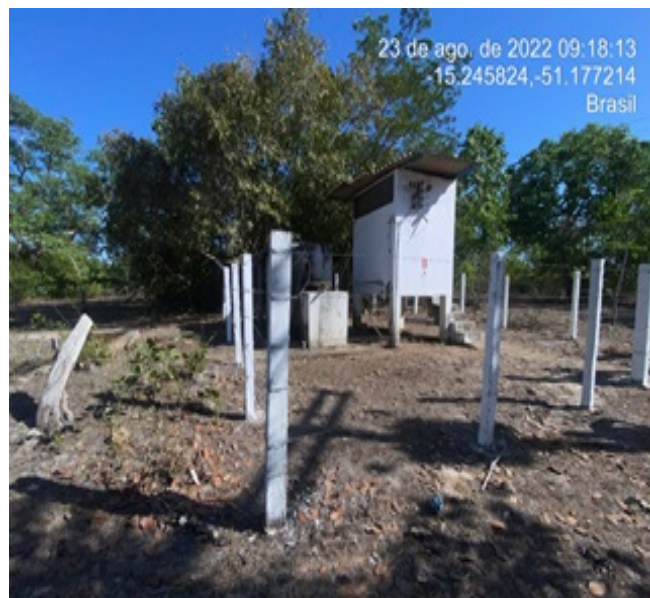
Foto 4 - EEAB com cerca de proteção da área urbanizada recuperada.
