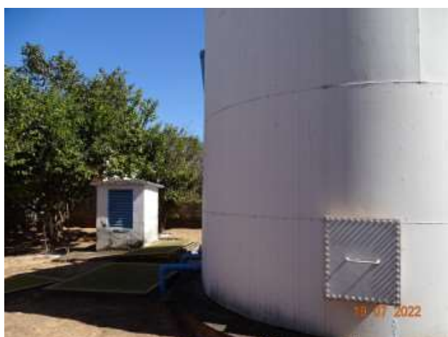
Foto 9 - RAP com ausência de corrosão e pintura recuperada.
