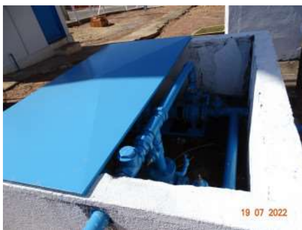
Foto 10 - EEAT com pintura recuperada.
