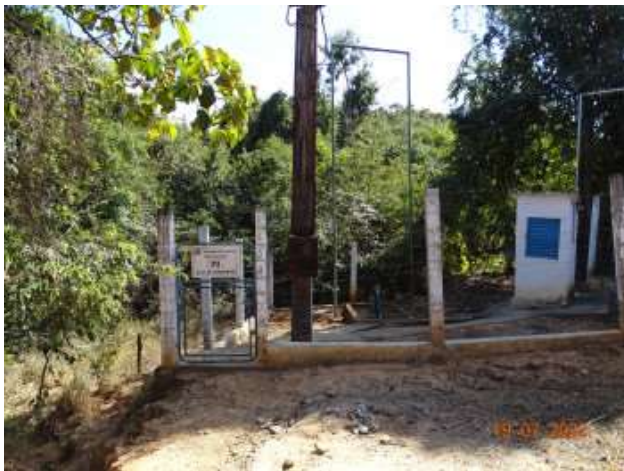
Foto 1 - Poço com cerca de proteção recuperada.
