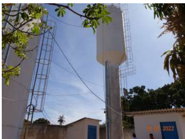
Foto 7 - REL com ausência de corrosão.
