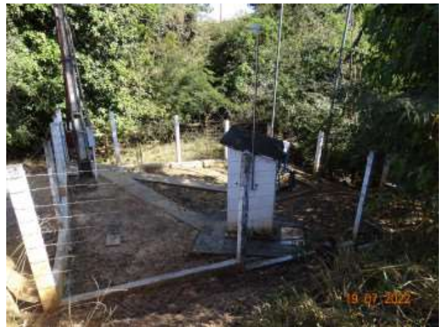
Foto 2 - Poço com cerca de proteção recuperada.
