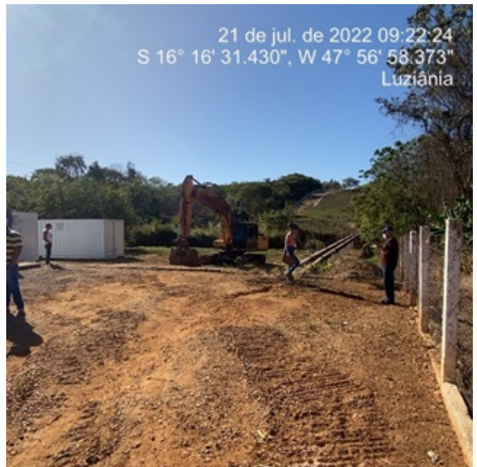
Foto 4 - Registro de máquina e equipamentos da empresa Conserva Solo Engenharia, contratada da Saneago.
