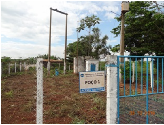
Foto 1 - Poço 01 com placa de identificação.
