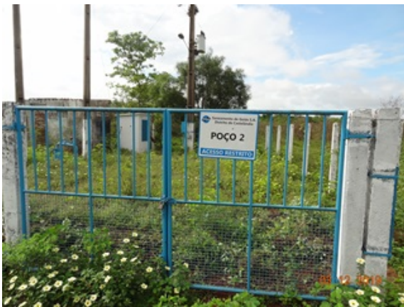
Foto 3 - Poço 02 com placa de identificação.
