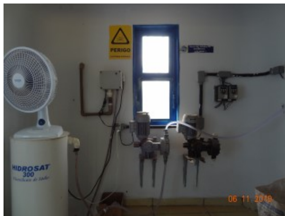
Foto 4 - Placa de advertência instalada.
