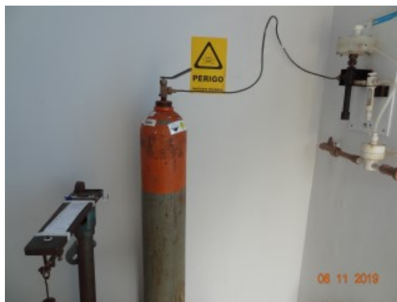
Foto 2 - Placa de advertência instalada.
