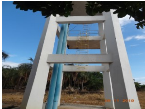
Foto 8 - Guarda-corpo instalado na parte inicial da escada do REL.
