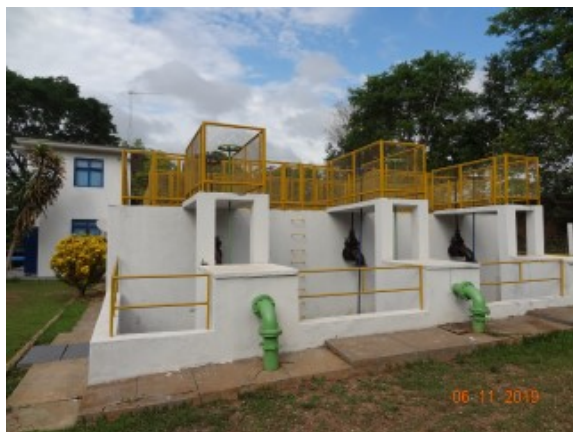
Foto 9 - Pintura, revestimento e infiltrações recuperados na ETA.
