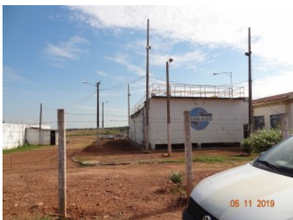
Foto 3 - Poço de contato com guarda-corpo.
