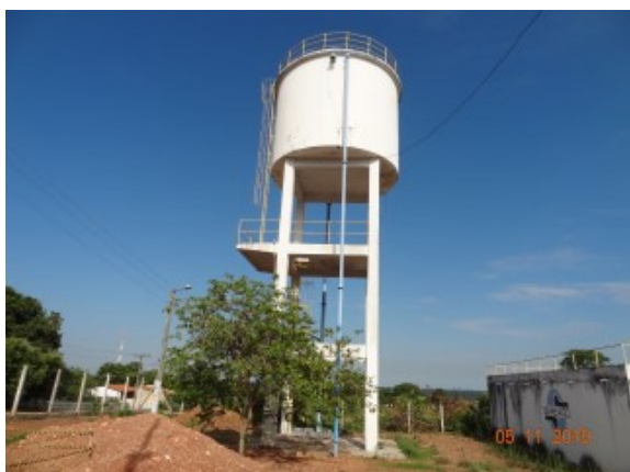
Foto 5 - Plataforma do REL da ETA.
