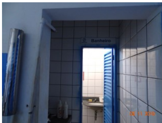
Foto 2 - Placa instalada no escritório comercial.
