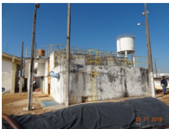
Foto 4 - Guarda-corpo instalado no topo do poço de contato.
