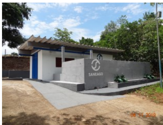
Foto 4 - Estrutura do poço de sucção recuperada.
