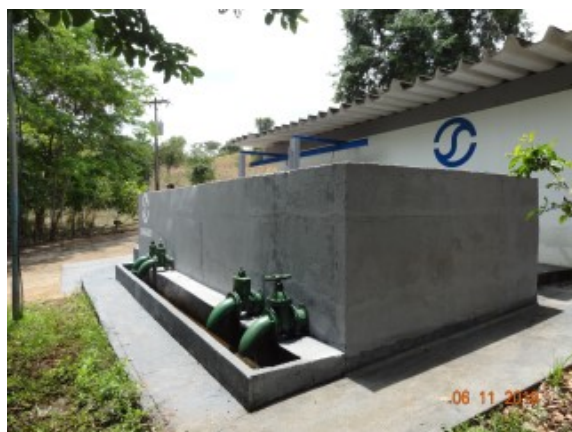
Foto 5 - Detalhe da estrutura do poço de sucção recuperada.
