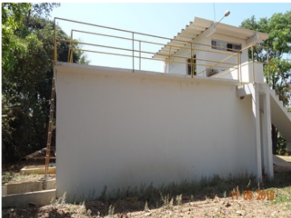
Foto 1 - ETA com estruturas recuperadas e ausência de infiltrações.
