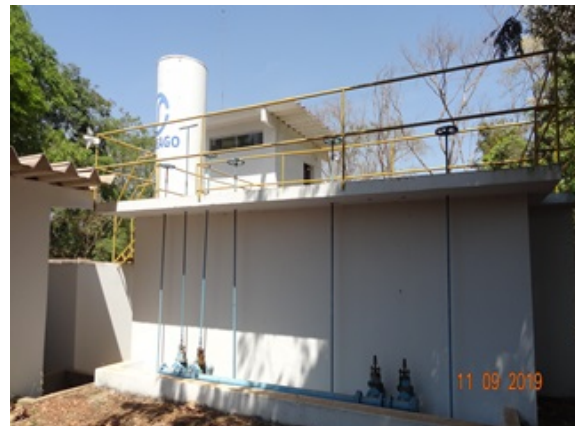
Foto 2 - ETA com estruturas recuperadas e ausência de infiltrações.
