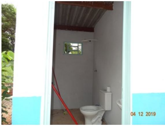
Foto 7 - EEE com banheiro, chuveiro e vaso sanitário.
