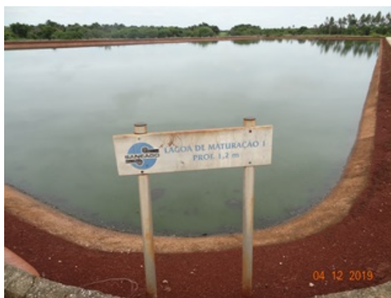
Foto 4 - Lagoa de maturação (1) com bordas recuperadas.
