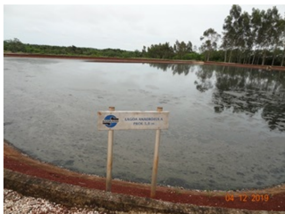
Foto 3 - Lagoa anaeróbia (A) com bordas recuperadas.
