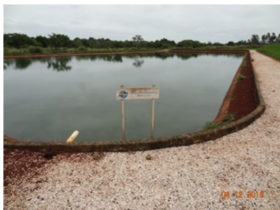
Foto 5 - Lagoa de maturação (2) com bordas recuperadas.
