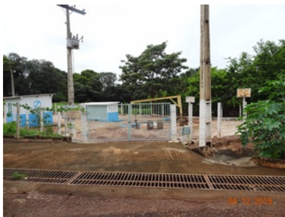
Foto 6 - Portão de entrada da EEE.
