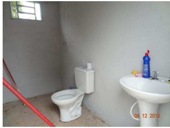
Foto 8 - Banheiro com lavabo e vaso sanitário.
