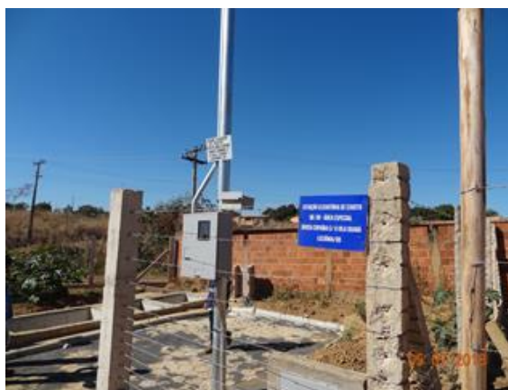
Foto 8 - Construção de uma Estação Elevatória de Esgoto na mesma área do Poço Copaíba - PGB 140.
