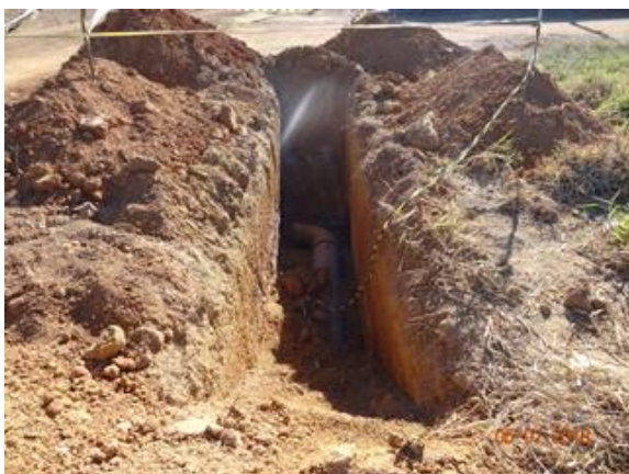
Foto 1 - obras de interligação dos poços PGB 51 e PGB 52.
