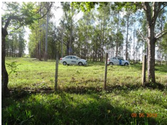
Foto 1 - Cerca de proteção danificada na área da captação.
