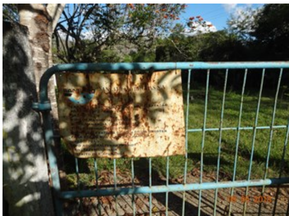
Foto 3 - Placa de identificação danificada na EEAB
