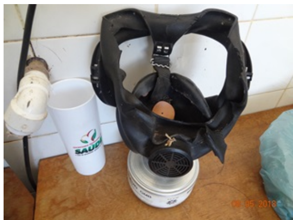
Foto 5 - Máscara de manuseio de cloro gasoso danificada.
