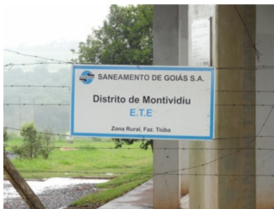
Foto 2 - Estação de Tratamento de Esgoto
