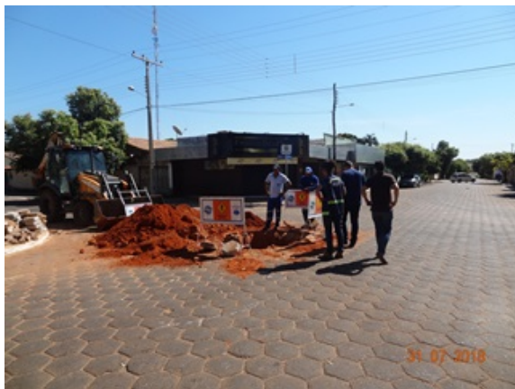
Foto 1 - Obras de modulação na cidade de Mozarlândia.
