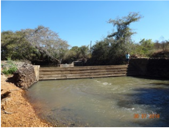
Foto 3 - Barragem de contenção na captação do Rio Palmeiral
