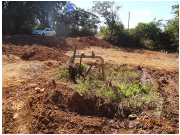
Foto 2 - Poço PGB 068 sem urbanização e energia.
