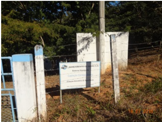
Foto 3 - Identificação da captação no Cór. Dirceu.
