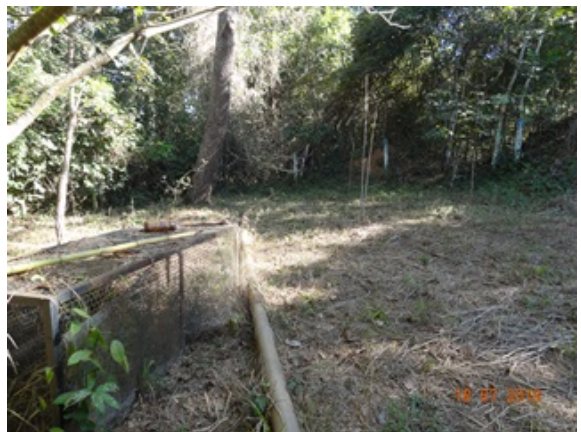
Foto 6 - Adutora (100 mm) interligada à reversão do Cór. das Cobras para EEAB do Cór. Dirceu.
