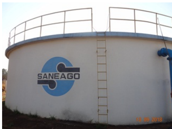
Foto 1 - Ausência de guarda-corpos.
