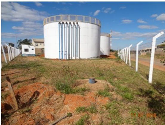
Foto 1 - Construção do Centro de Reservação Mossoró.
