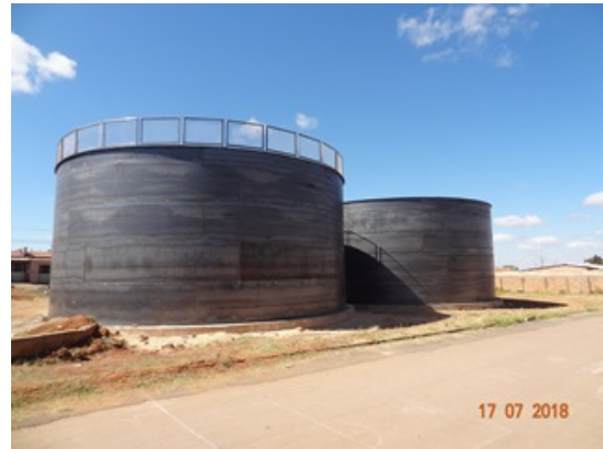
Foto 4 - Céu Azul, construção de dois reservatórios RAP's de 1000 m 3 cada um.
