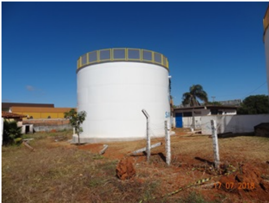
Foto 3 - Valparaíso II, construção de um reservatório RAP 500 m 3 metálico.
