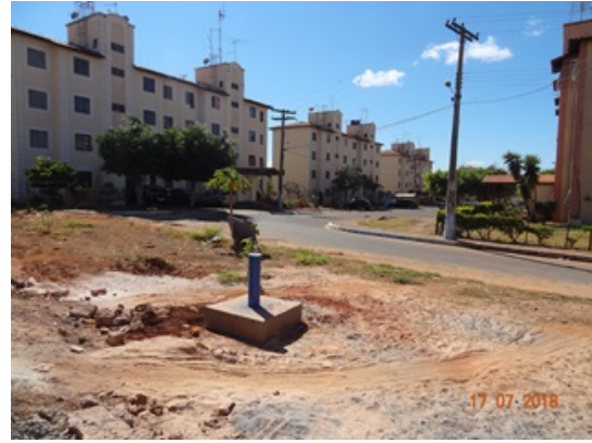
Foto 2 - Cidade Jardins, poço perfurado aguardando documentos de posse.
