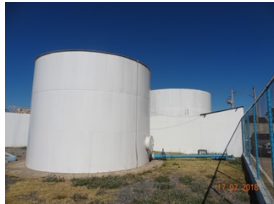
Foto 6 - Esplanada III/C.R. dois RAP's metálico com 100 m 3 cada um.
