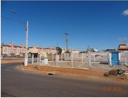
Foto 1 - Cidade Jardins, poço interligado ao SAA/ETA.
