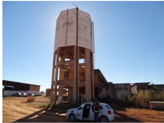
Foto 10 - Setor Marajó REL 400 m³ concreto.
