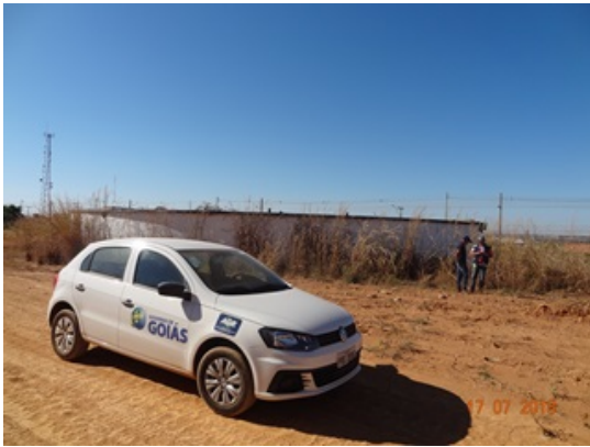
Foto 9 - Setor Marajó RAP 3500 m³ concreto.
