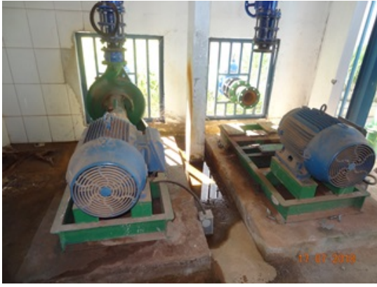
Foto 7 - Esplanada III/C.R. EEAB.
