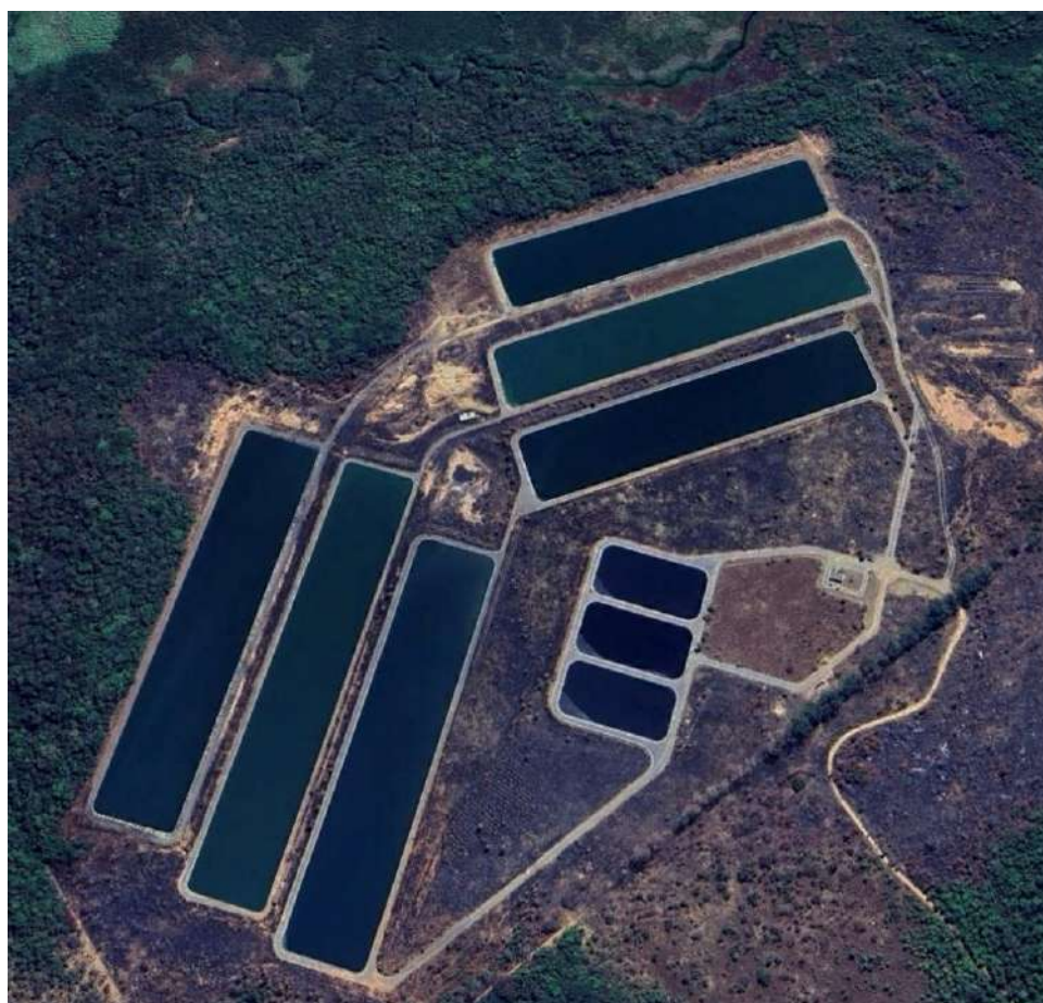
Figura 58 – Vista da ETE Formosa.
