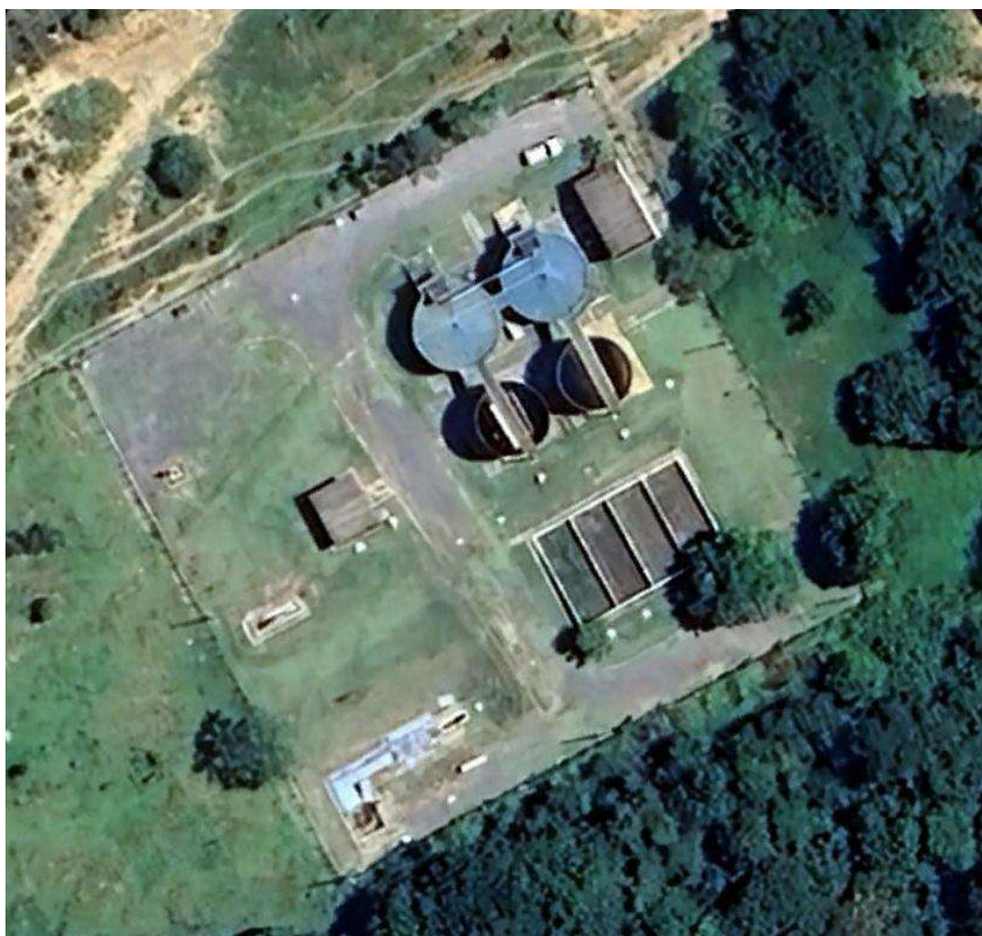
Figura 115 – Vista da ETE Parque Marajó.
