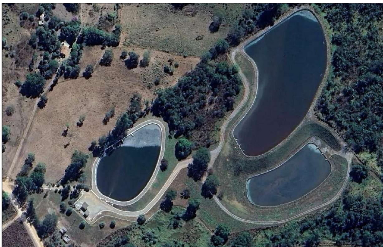
Figura 34 – Vista da ETE Campos Belos.
