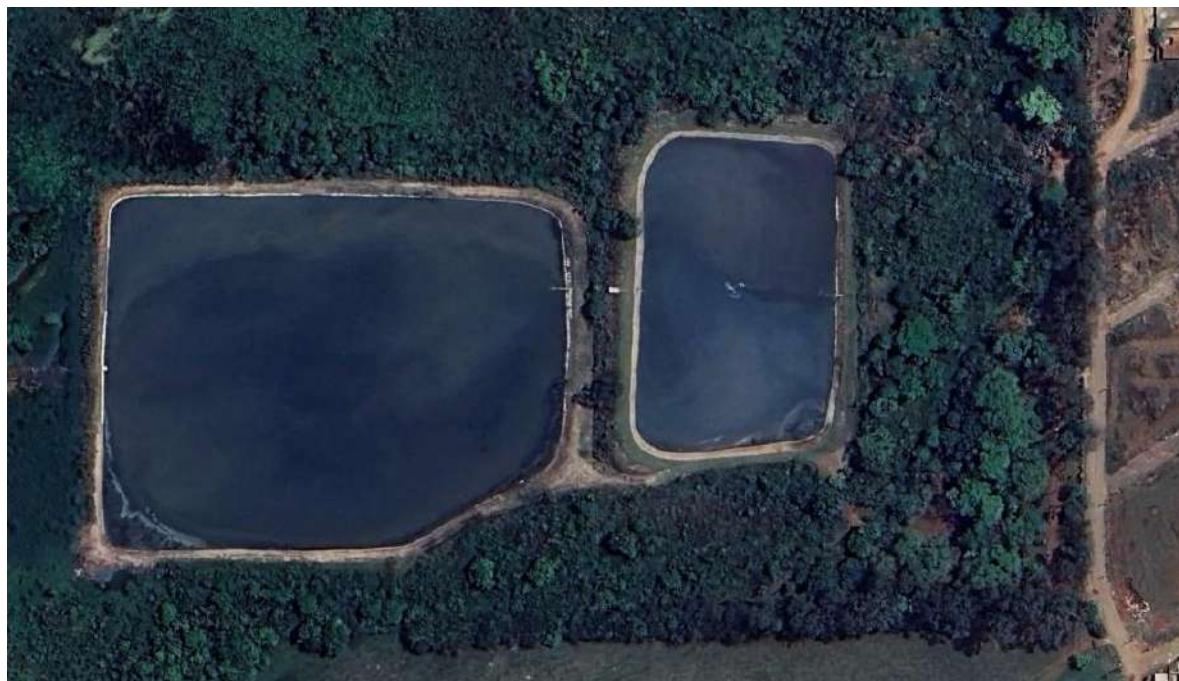
Figura 85 – Vista da ETE Pires do Rio.
