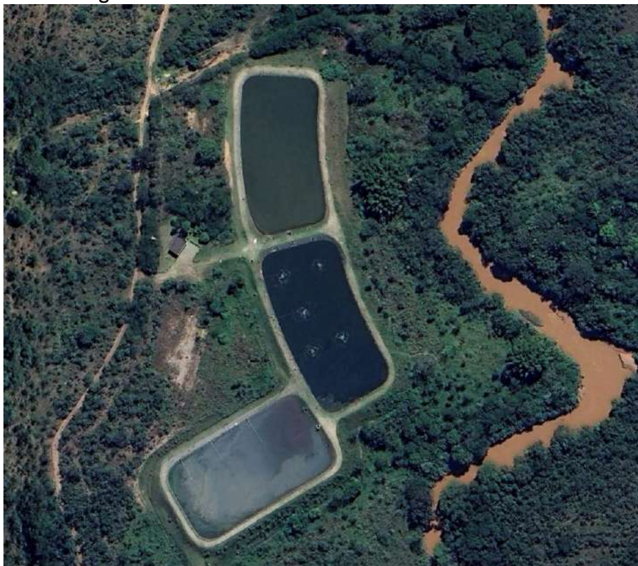
Figura 98 – Vista da ETE Santo Antonio do Descoberto.
