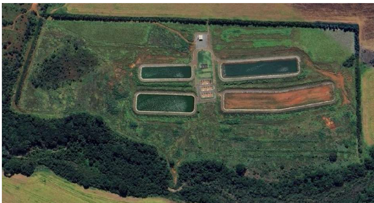
Figura 119 – Vista da ETE Vianópolis.
