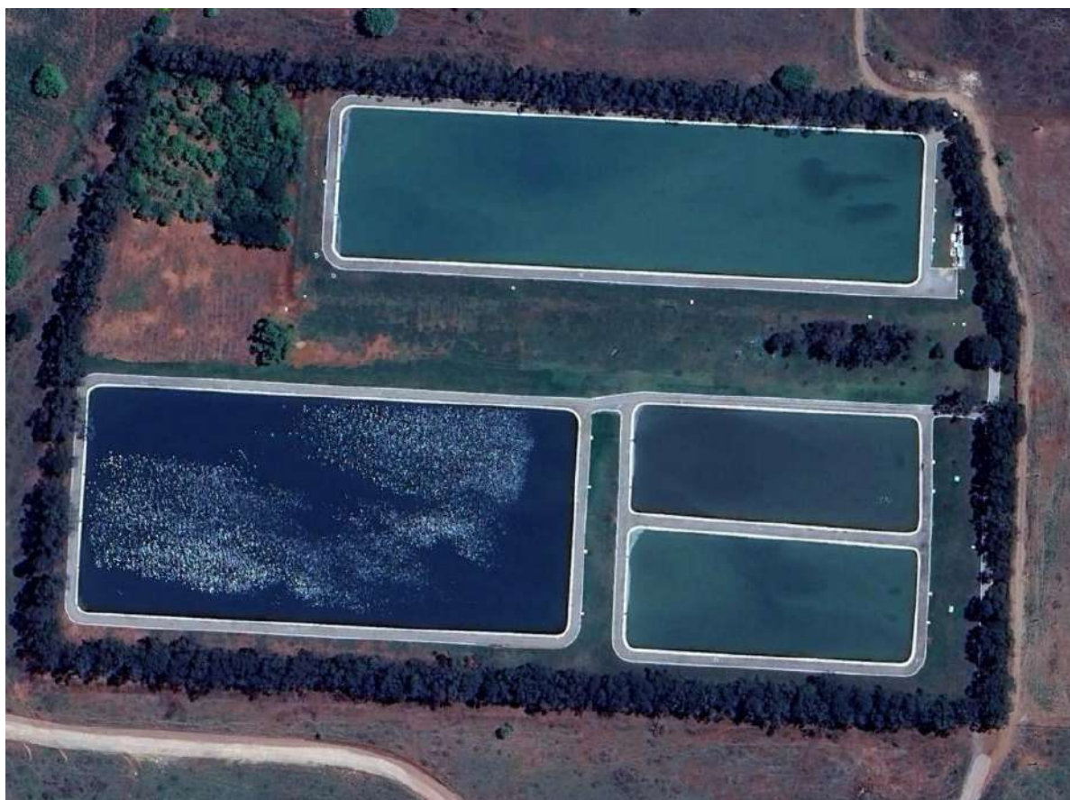
Figura 81 – Vista da ETE Padre Bernardo.
