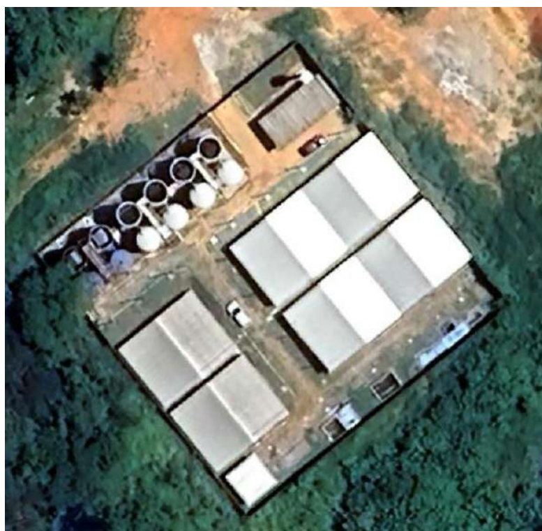
Figura 108 – Vista da ETE Reserva do Paraíso.
