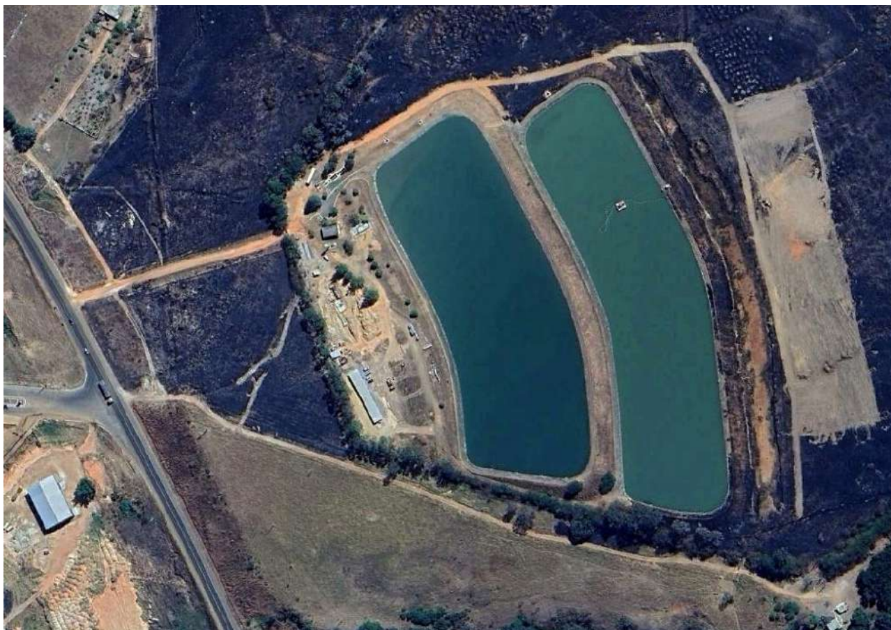
Figura 54 – Vista da ETE Cristalina.
