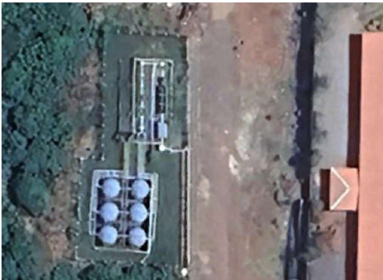
Figura 111 – Vista da ETE Guaíra.
