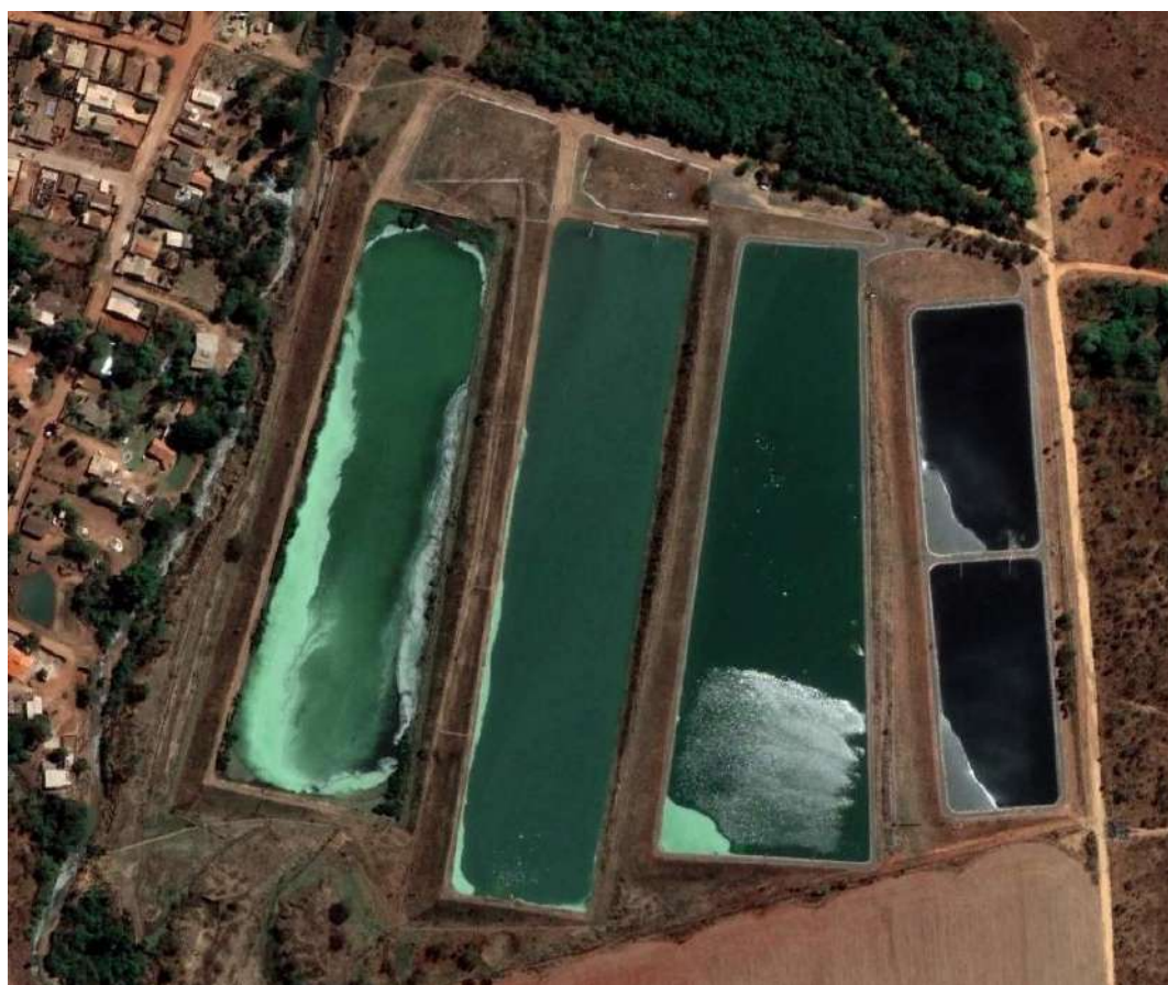
Figura 65 – Vista da ETE Rio Vermelho.
