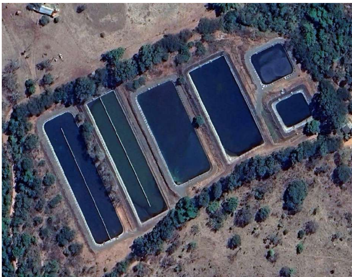
Figura 49 – Vista da ETE Corumbaíba.
