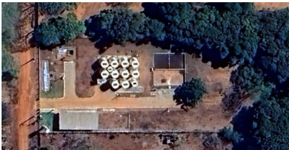
Figura 64 – Vista da ETE Raquel Pimentel.
