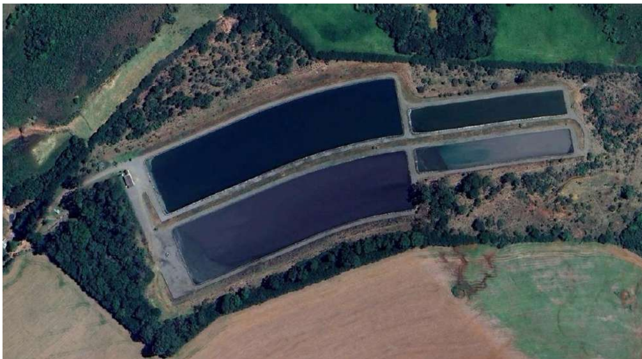
Figura 102 – Vista da ETE Silvânia.
