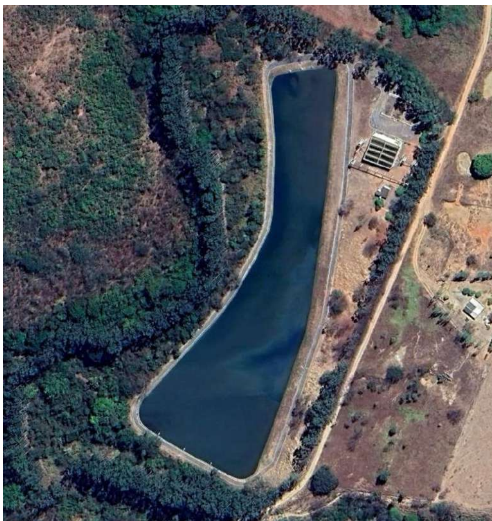
Figura 94 – Vista da ETE Posse
