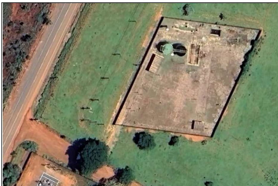
Figura 44 – Vista da ETE DAMHA.
