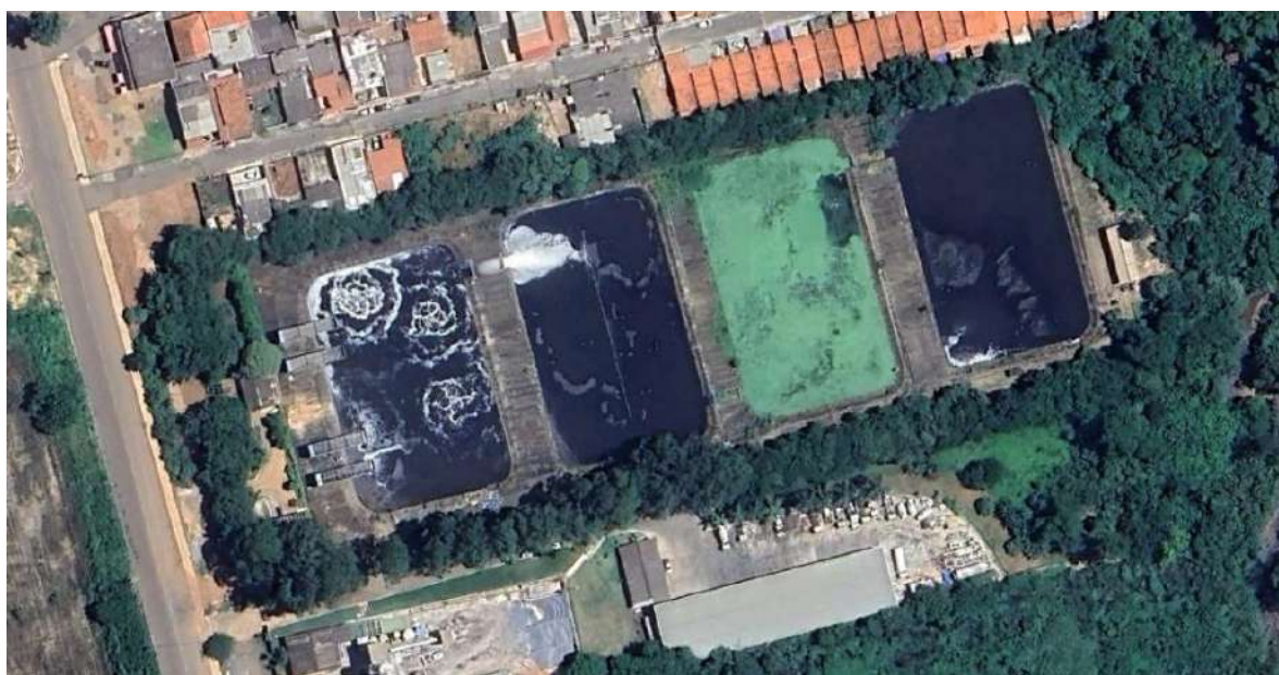
Figura 107 – Vista da ETE Etapa B.
