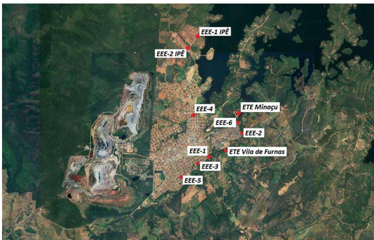
Figura 66 - Imagem aérea da Sede municipal – Minaçu.
