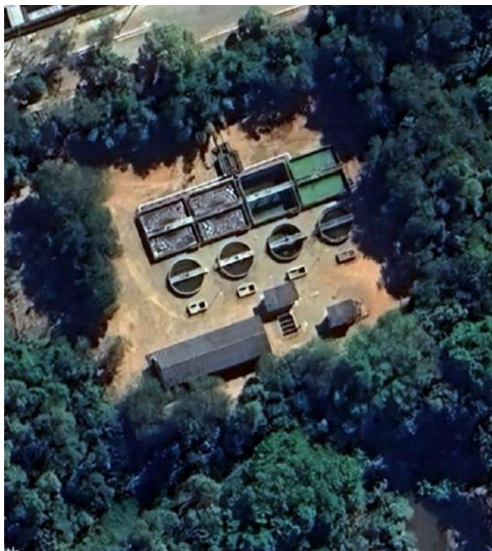
Figura 72 – Vista da ETE Vila de Furnas.
