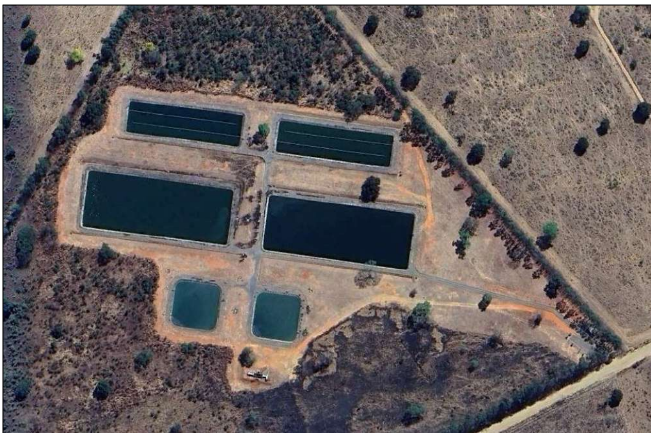
Figura 30 – Vista da ETE Alvorada do Norte.
