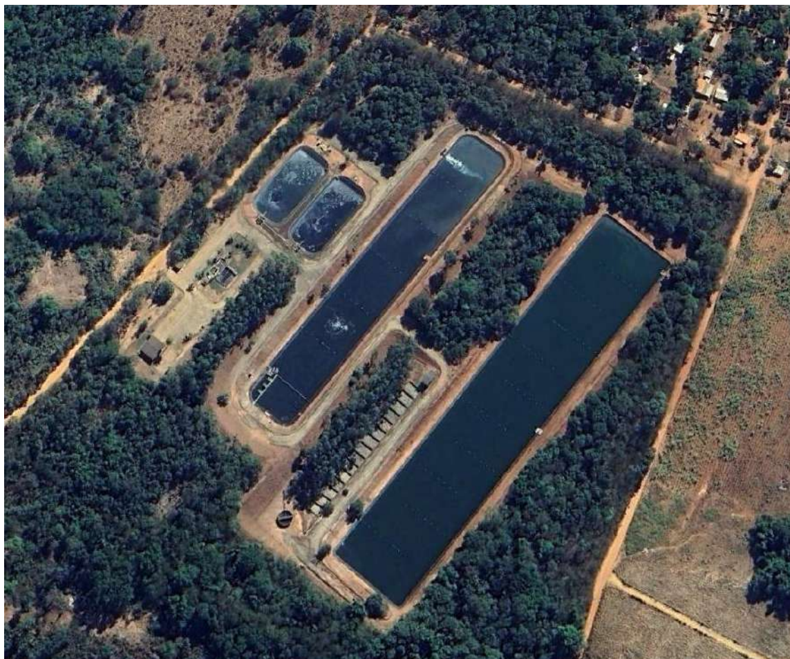
Figura 69 – Vista da ETE Minaçu.
