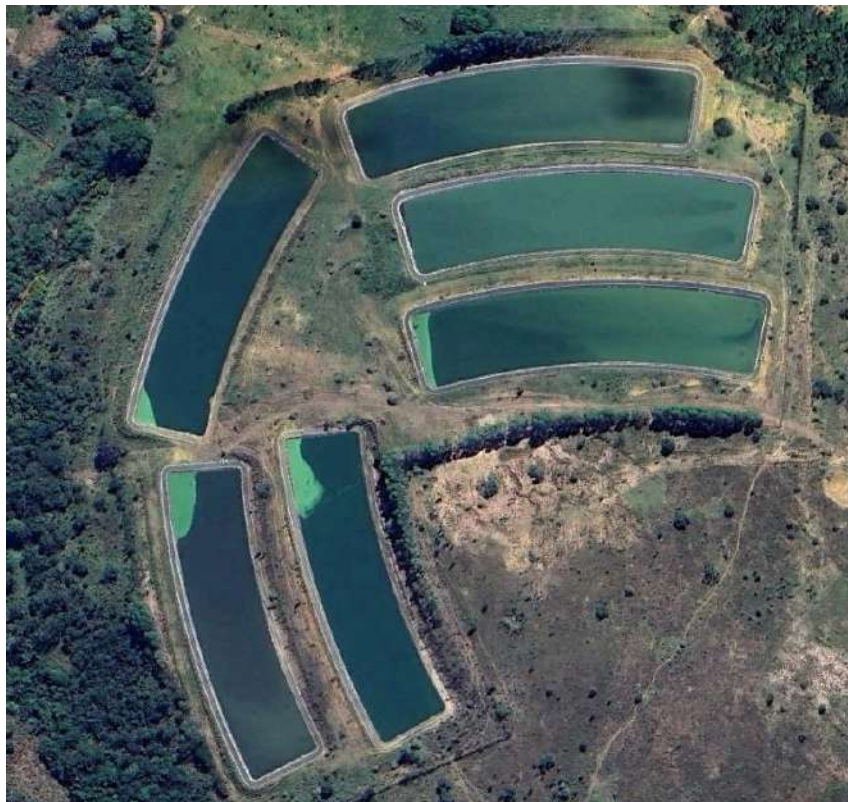
Figura 77 – Vista da ETE Lagoa Azul.
