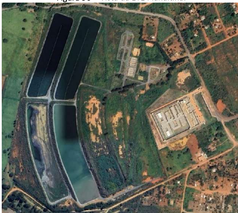
Figura 90 – Vista da ETE Planaltina.
