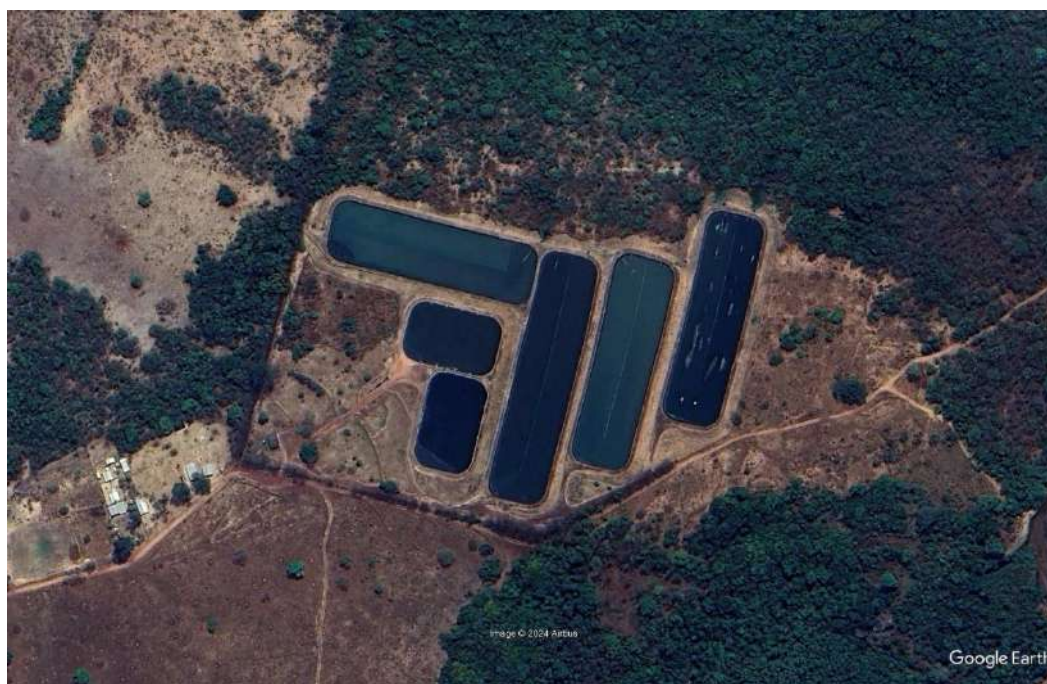
Figura 68 – Imagem aérea do ETE Caiapônia
