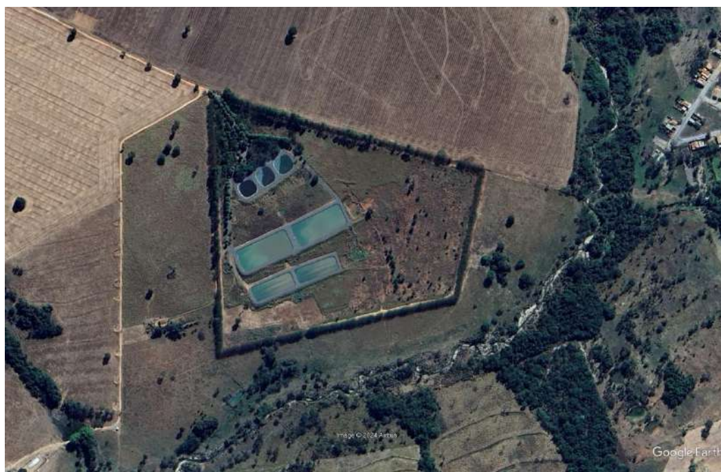
Figura 73 – Imagem aérea da ETE Edéia
