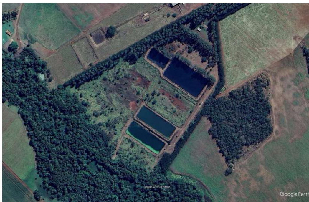
Figura 31 – Imagem aérea da ETE Acreúna.
