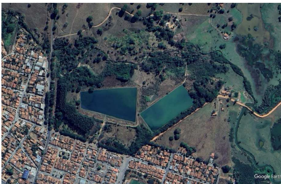
Figura 36 – Imagem aérea da ETE Anicuns.
