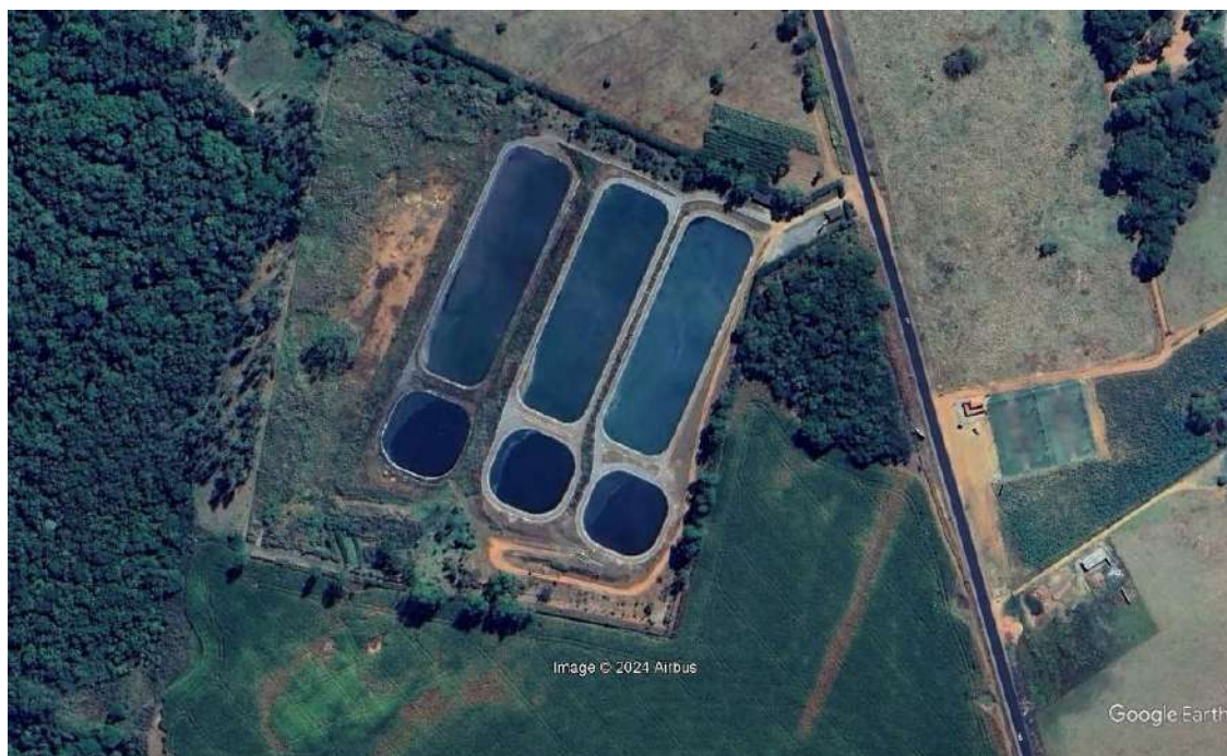
Figura 93 – Imagem aérea da ETE Itaberaí
