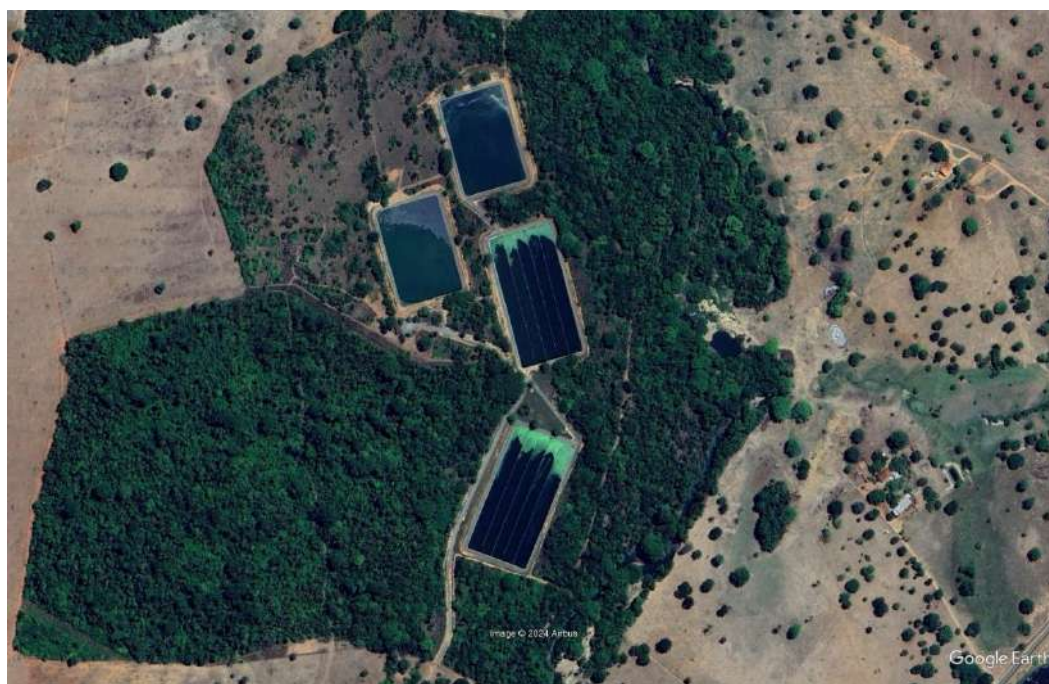
Figura 103 – Imagem aérea do ETE Jussara
