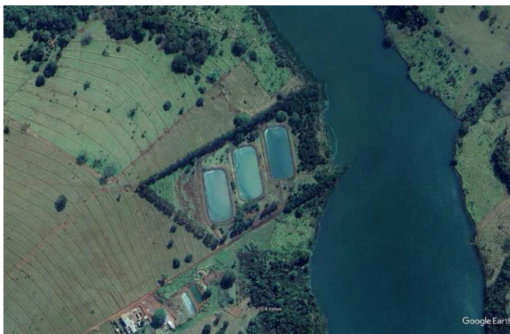
Figura 63 – Imagem aérea da ETE Caçu.
