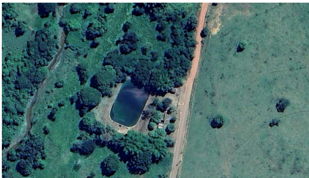
Figura 151 - Imagem aérea do ETE São João da Paraúna
