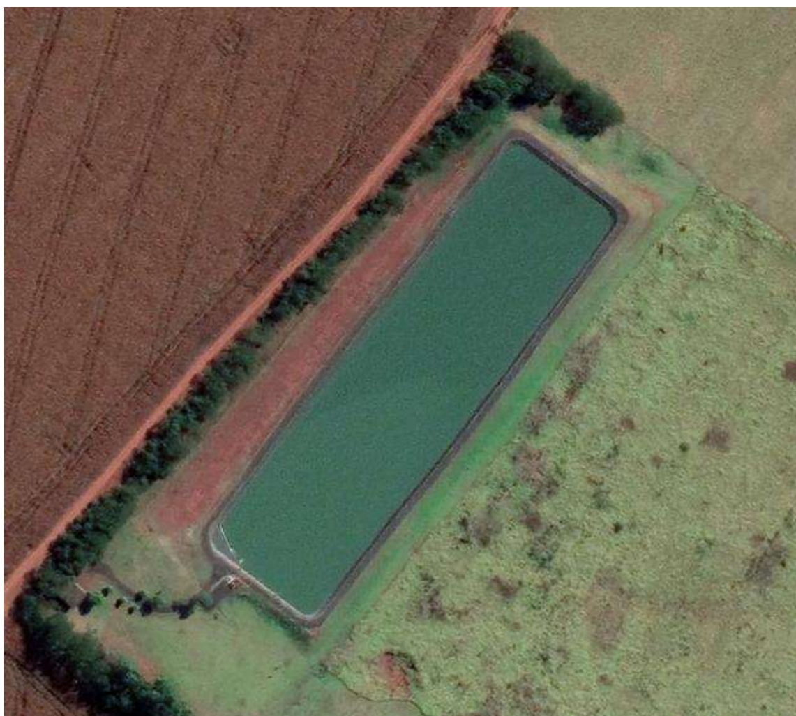
Figura 117 – Imagem aérea da ETE Montividiu
