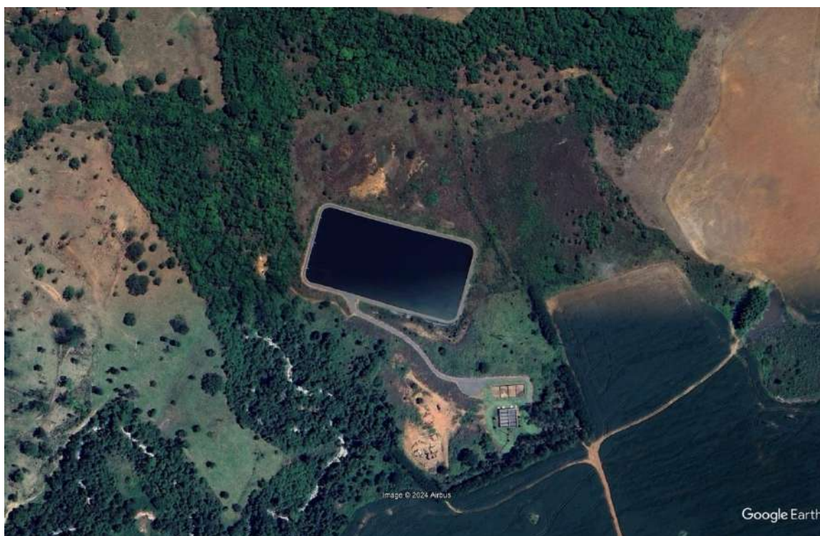
Figura 88 – Imagem aérea do ETE Iporá
