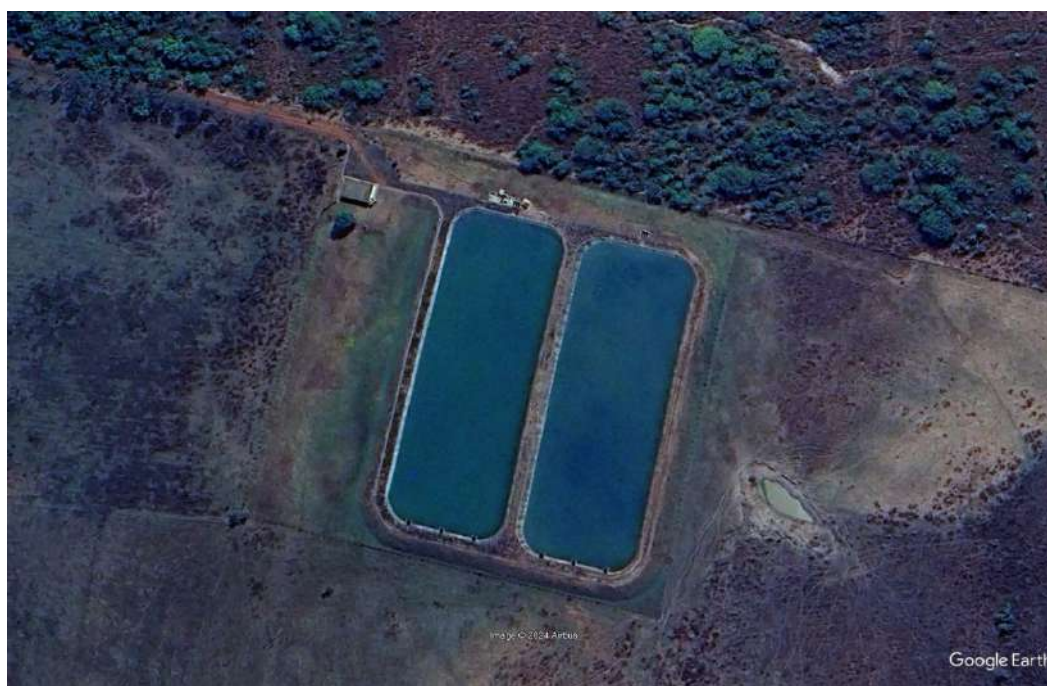
Figura 108 – Imagem aérea do ETE Lagoa Santa
