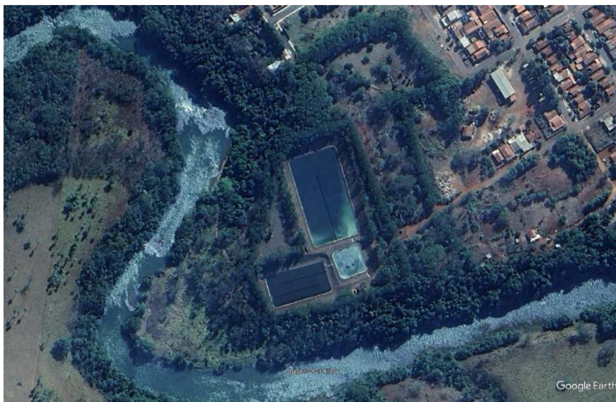
Figura 41 - Imagem aérea da ETE Aparecida do Rio Doce.
