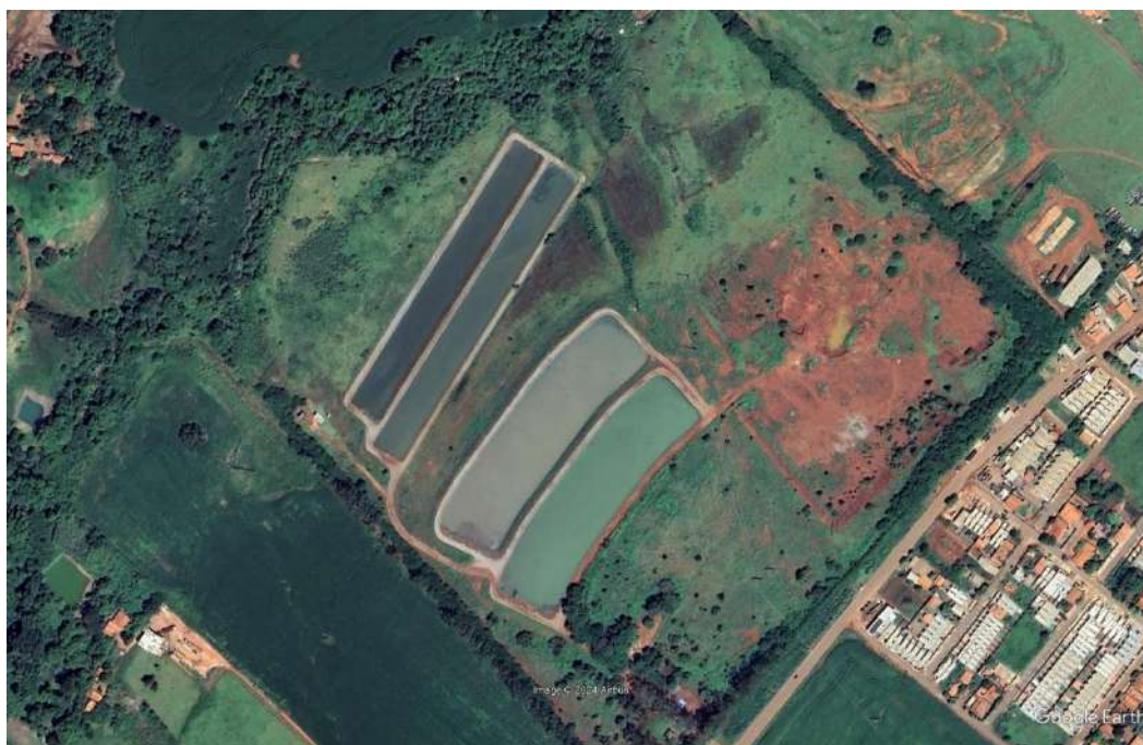
Figura 121 – Imagem aérea do ETE Palmeiras de Goiás
