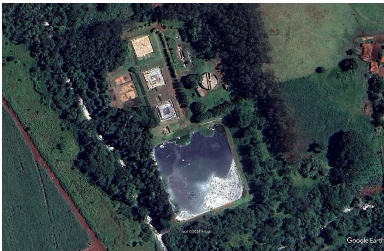
Figura 136 – Imagem aérea da ETE Quirinópolis
