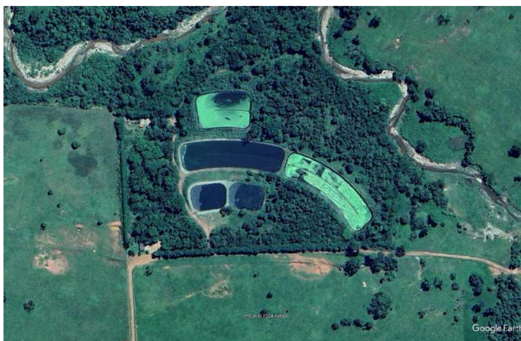
Figura 126 – Imagem aérea do ETE Paraúna
