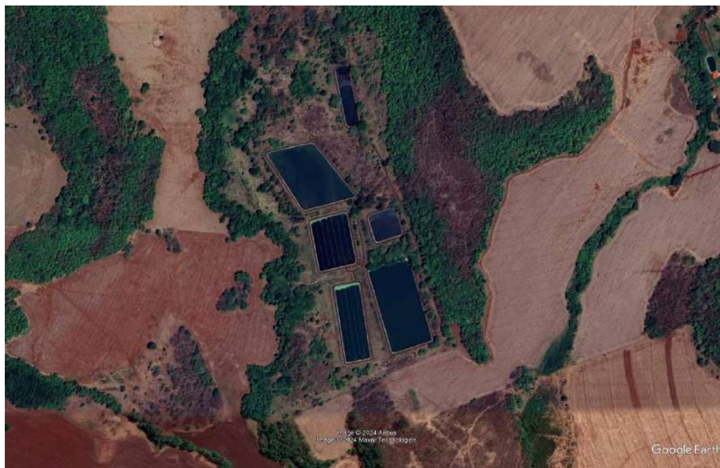
Figura 83 – Imagem aérea da ETE Goiatuba
