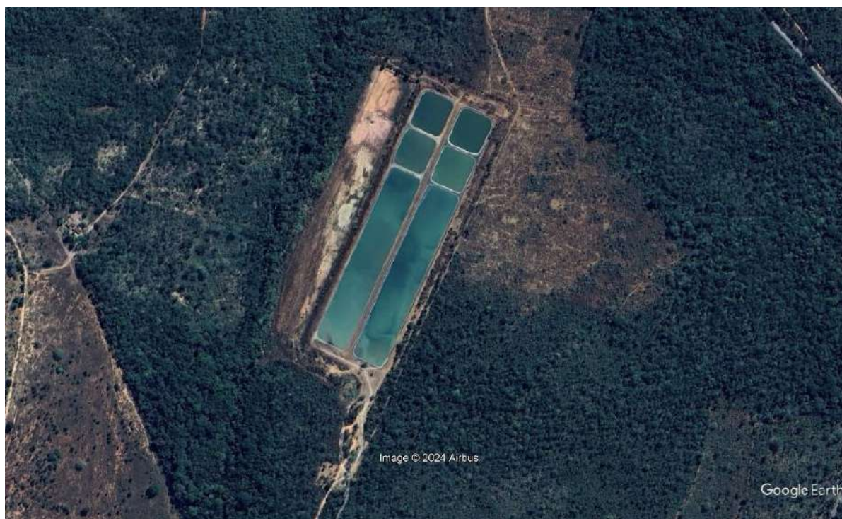
Figura 140 - Imagem aérea da ETE Uruaçu
