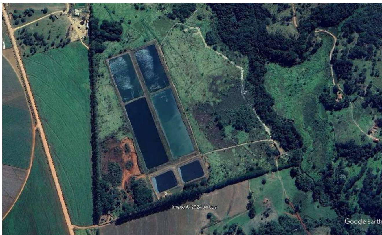
Figura 103 - Imagem aérea da ETE Morrinhos
