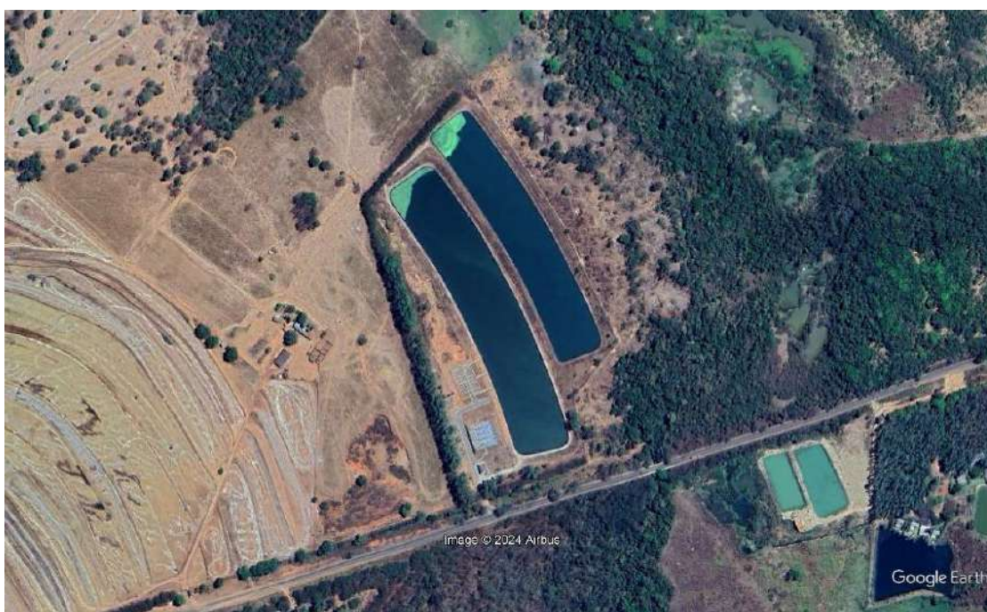
Figura 122 - Imagem aérea da ETE Porangatu
