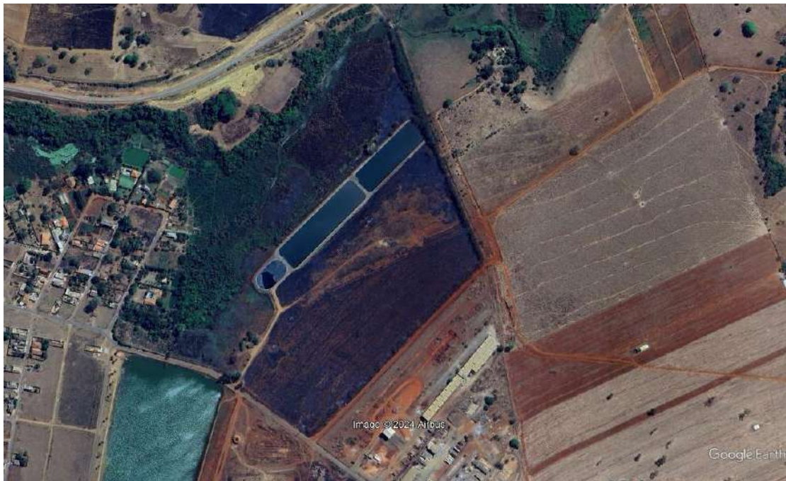
Figura 61 - Imagem aérea da ETE Goianira.
