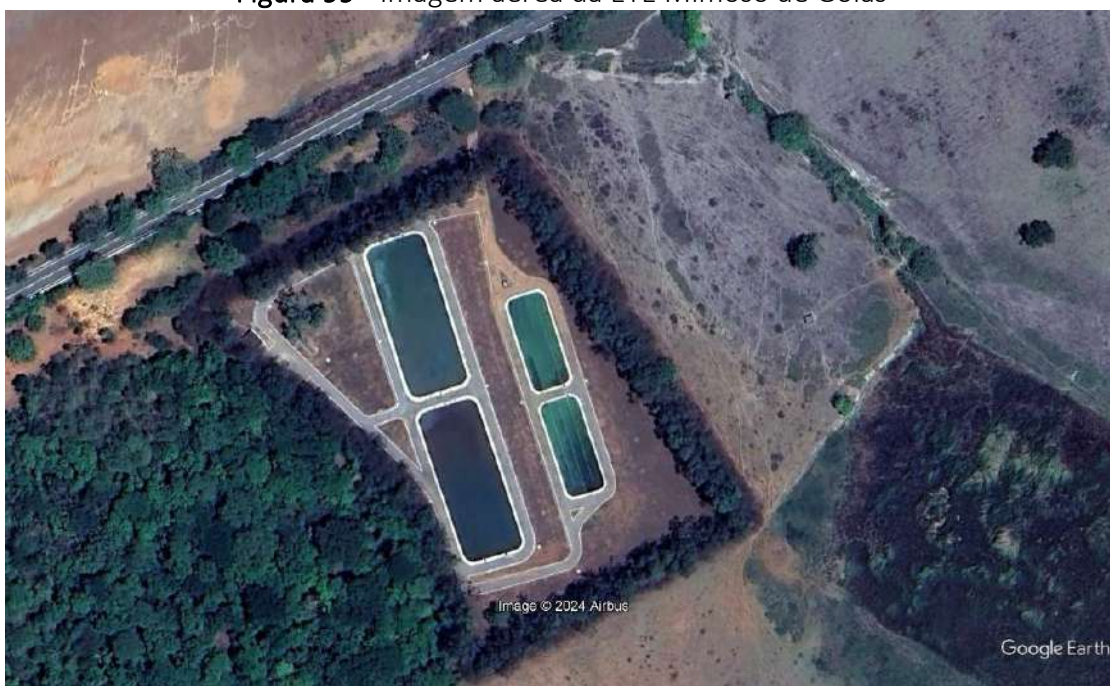
Figura 99 - Imagem aérea da ETE Mimoso de Goiás
