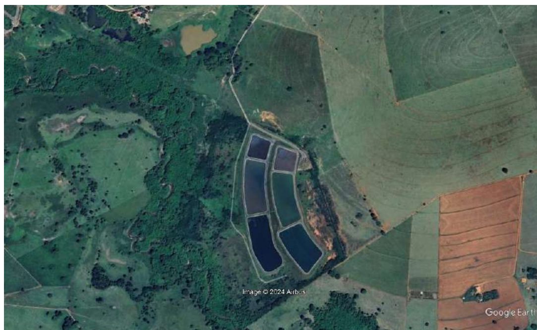
Figura 74 - Imagem aérea da ETE Itapuranga.
