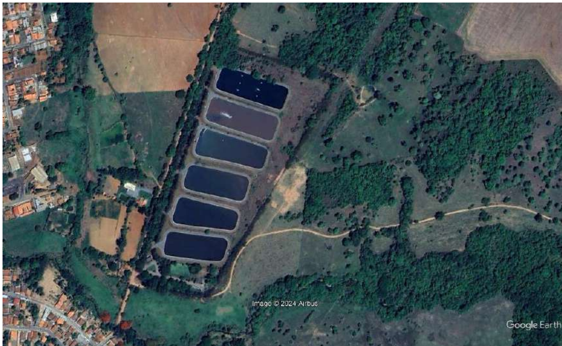
Figura 112 - Imagem aérea da ETE Piracanjuba
