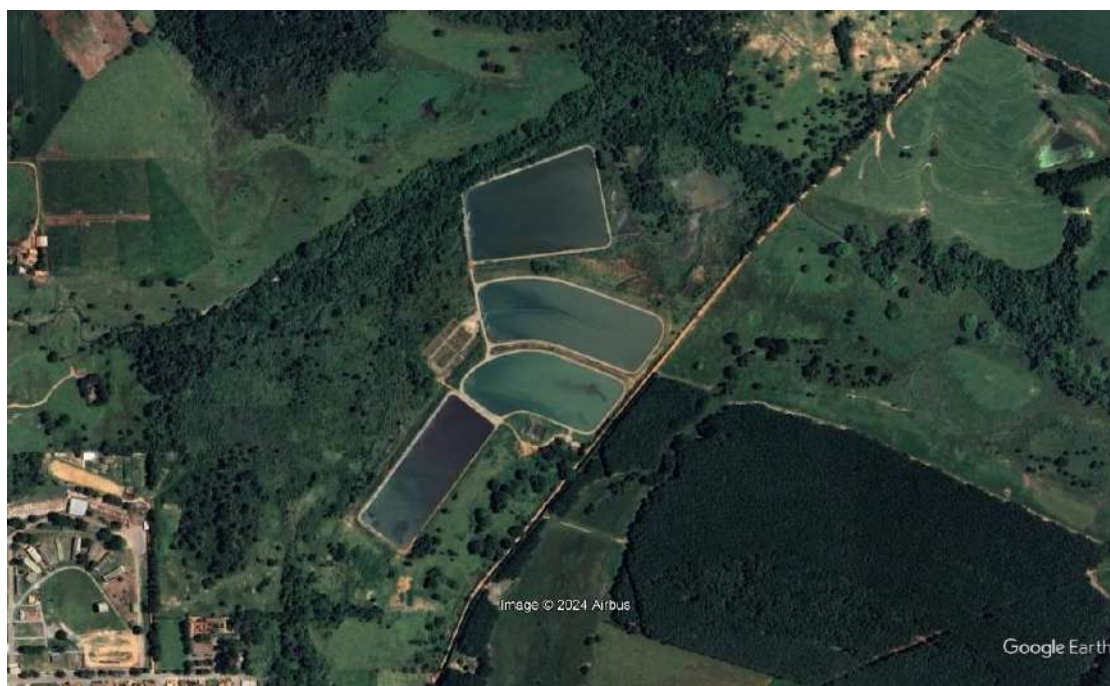
Figura 56 - Imagem aérea da ETE Goianésia.
