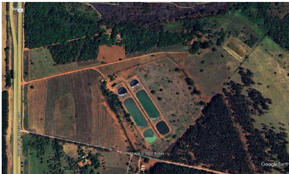
Figura 42 – Imagem aérea da ETE Bela Vista de Goiás.
