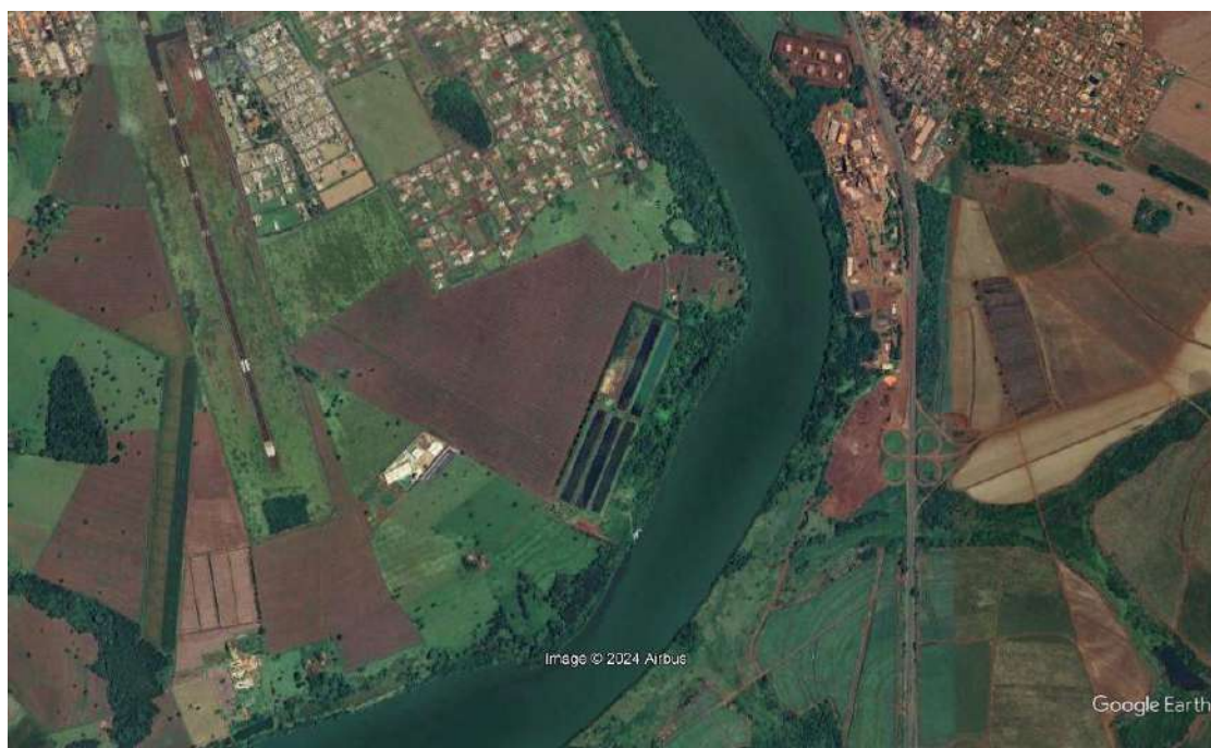
Figura 84 - Imagem aérea da ETE Itumbiara.
