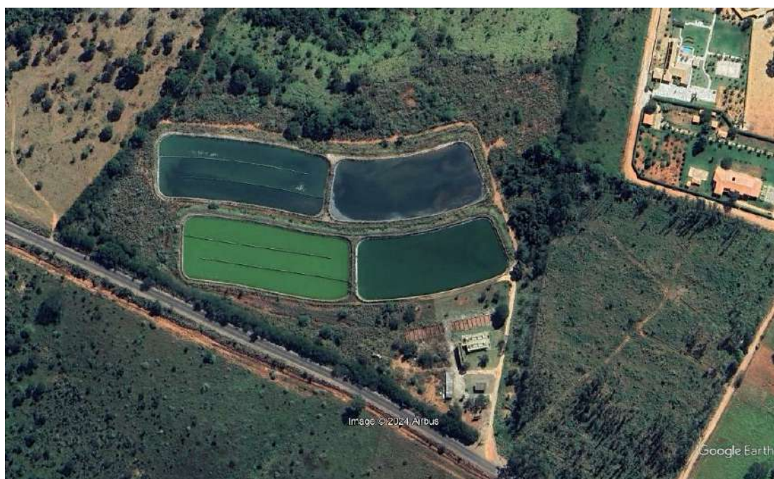
Figura 117 - Imagem aérea da ETE Pirenópolis
