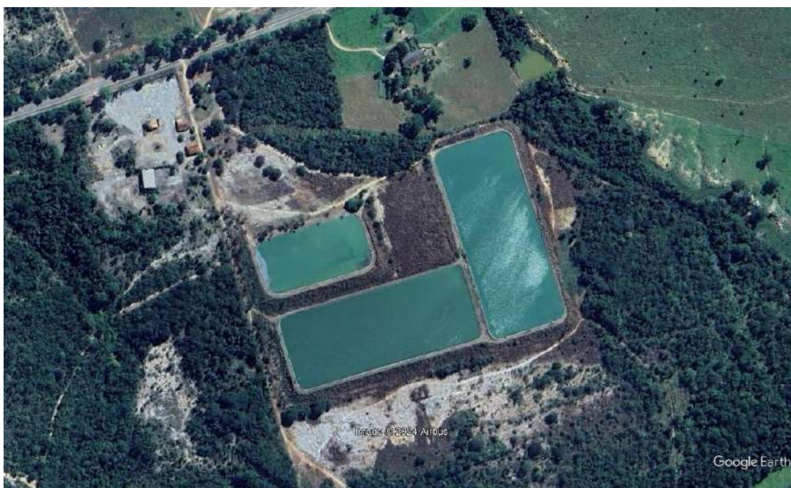
Figura 108 - Imagem aérea da ETE Niquelândia
