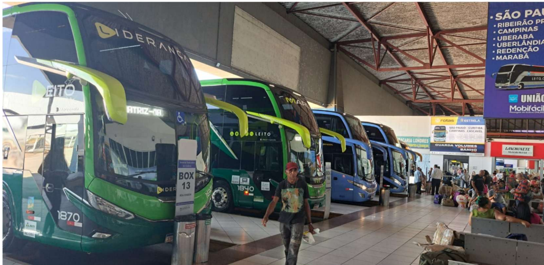
Figura 29. Terminal Rodoviário de Passageiros de Goiânia (Maia e Borba S/A)
