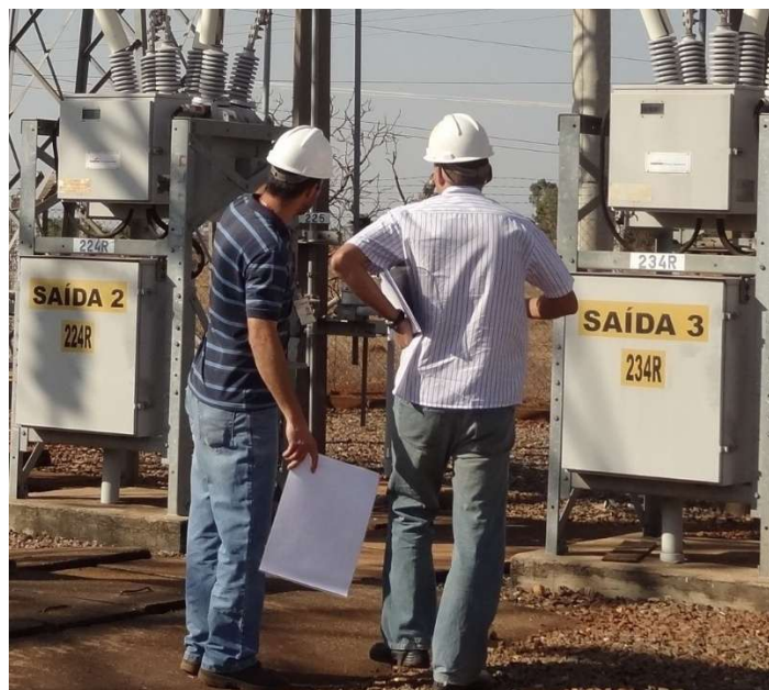
Figura 49. Fiscalização de Energia Elétrica em Subestação
