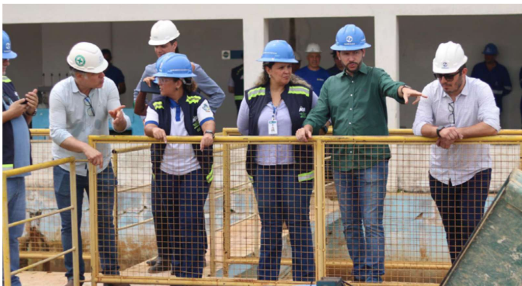
Figura 10. Fiscalização do Saneamento Básico
