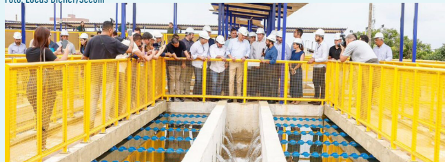
ETA de Anápolis com capacidade duplicada após ampliação
