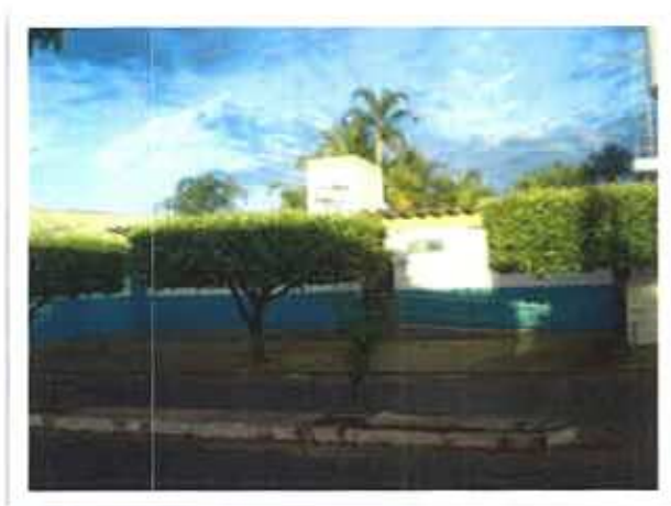
Figura 5: Escritório e Reservatório Elevado
