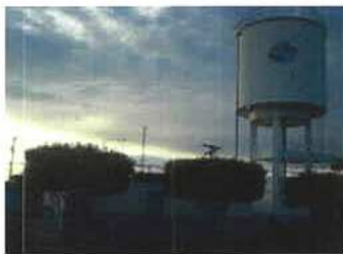
Figura 8: ETA e Reservatório
