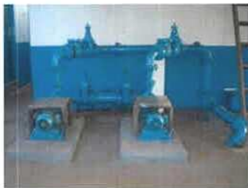
Figura 9: Conjunto Moto-Bombas
