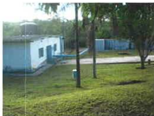
Figura 6: Casa de Bombas e Caixa Desarenadora
