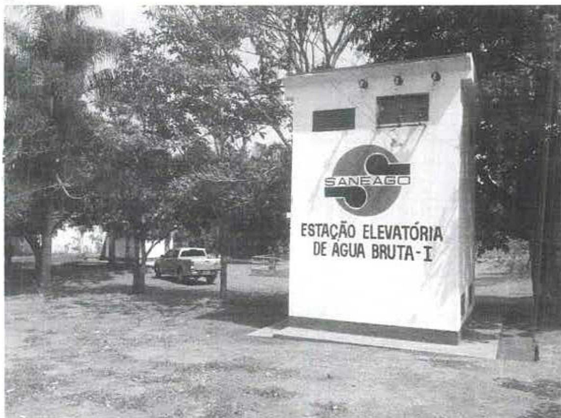
Figura 10: Estação Elevatória de Água Bruta I (EEABI – Palmital)
