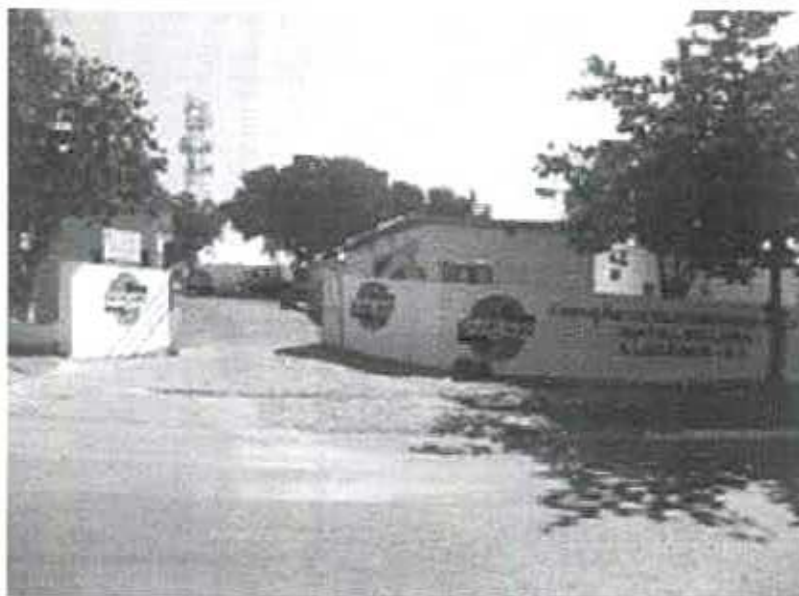
Figura 13: Estação de Tratamento de Água (ETA) Natal de Lima
