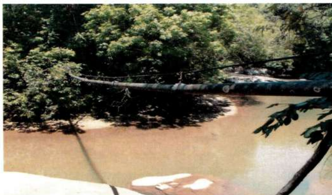
Figura 5- Tubulação da captação da Lapinha (Gruta) sentido reservatório.
