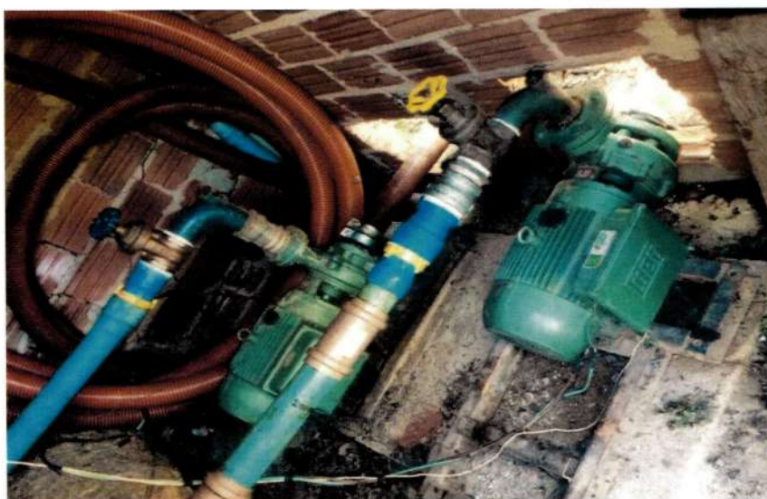
Figura 7- Casa de bombas da EEAB do Rio Muquém
