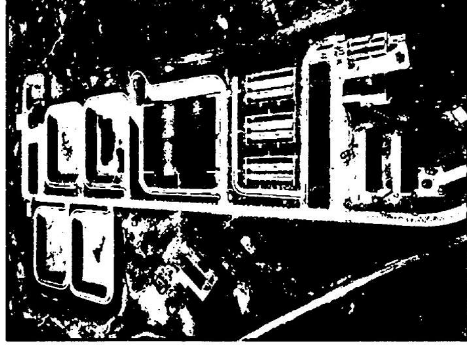
Foto aérea da ETE Águas Lindas finalizada
