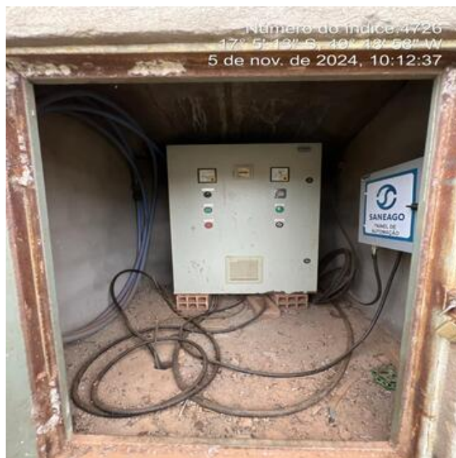
Foto 8 - Poço P8 com quadro de comando sem aviso de risco.
