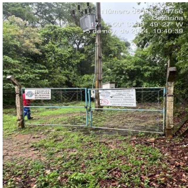
Foto 10 - Poço P7 com cerca de proteção danificada.
