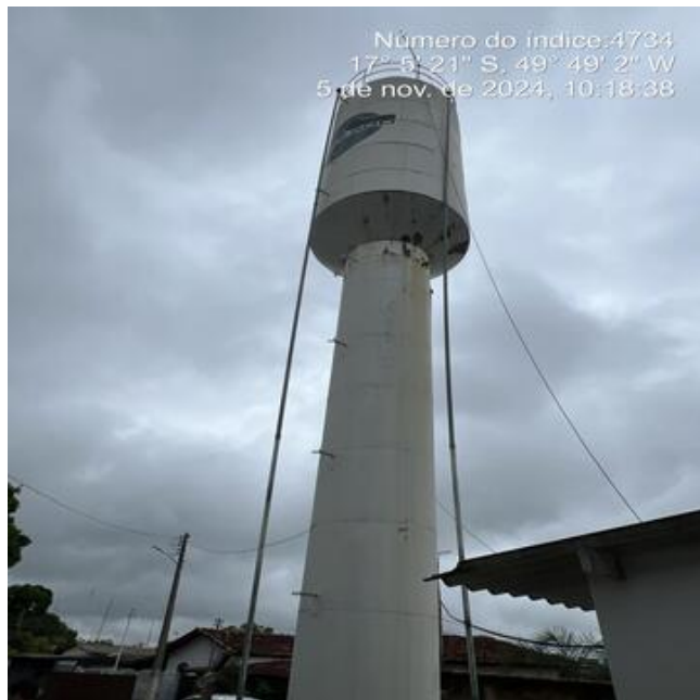
Foto 19 - C.R. Linda Vista, REL/50 m 3 metálico com corrosão.
