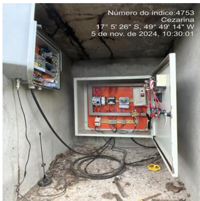
Foto 6 - Poço P1 com quadro de comando sem aviso de risco.
