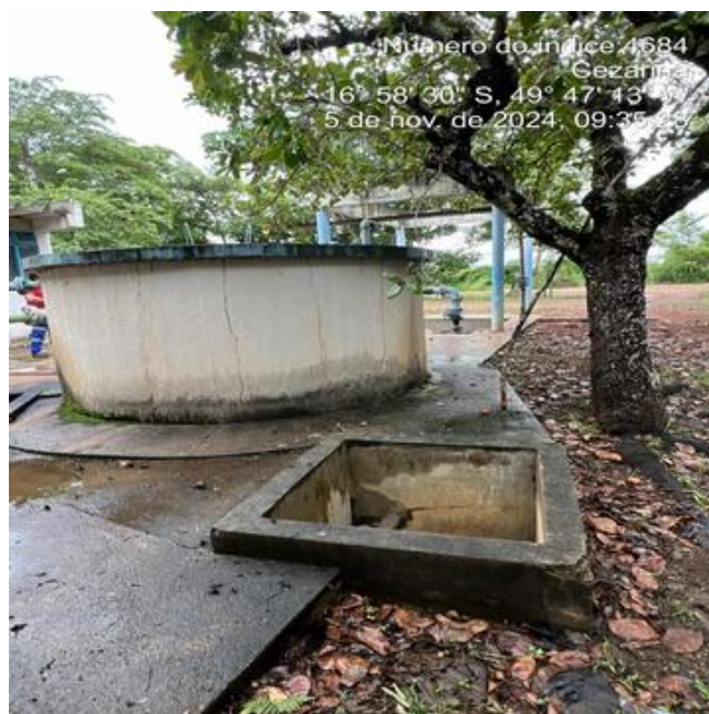
Foto 6 - ETA/Caixas de passagem sem tampa ou grade de proteção.
