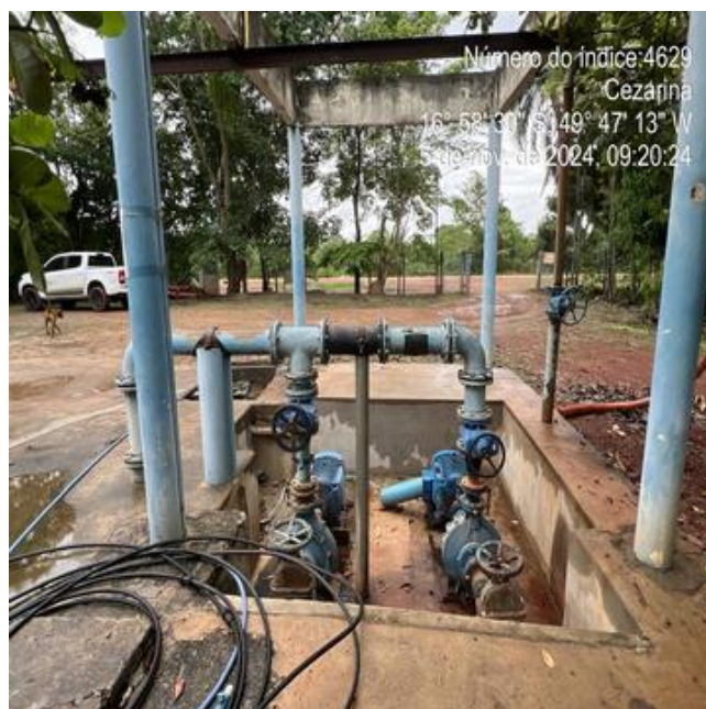
Foto 12 - ETA/EEAT com ausência de grade de proteção.
