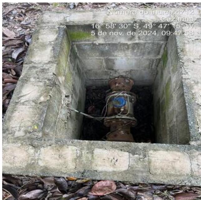
Foto 19 - ETA/Caixas de passagem sem tampa ou grade de proteção.
