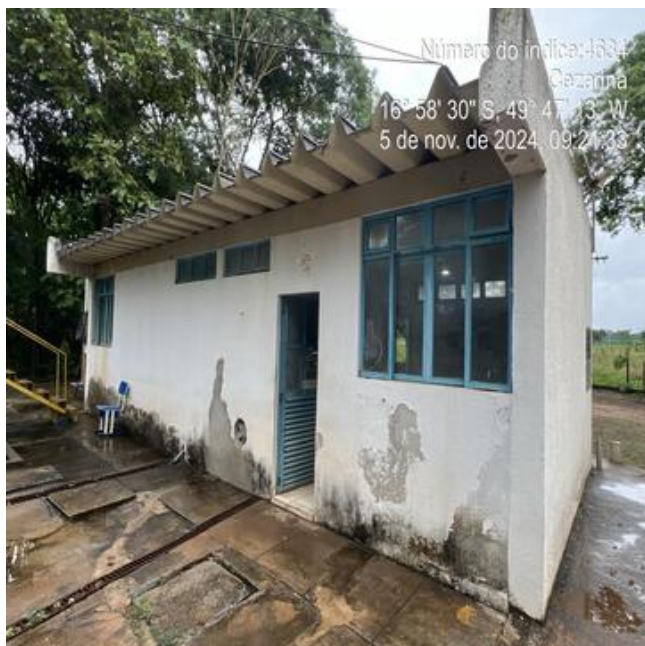
Foto 3 - ETA/Edificações com perda de revestimento e pintura desgastada.
