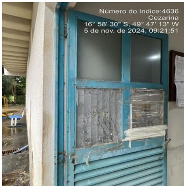
Foto 4 - ETA/Edificações com perda de revestimento, pintura desgastada, porta com vidros quebrados.
