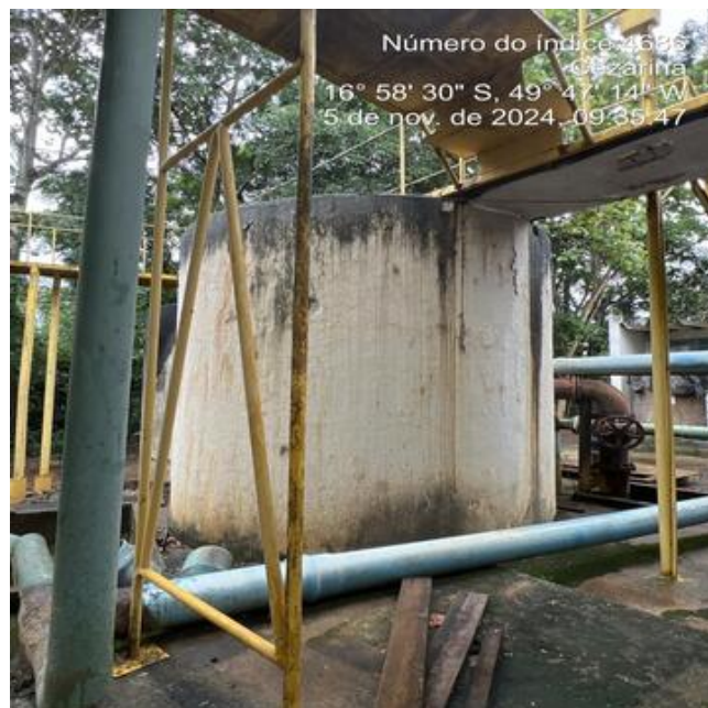
Foto 8 - ETA/Filtração perda de revestimento, ferragem exposta e pintura desgastada.
