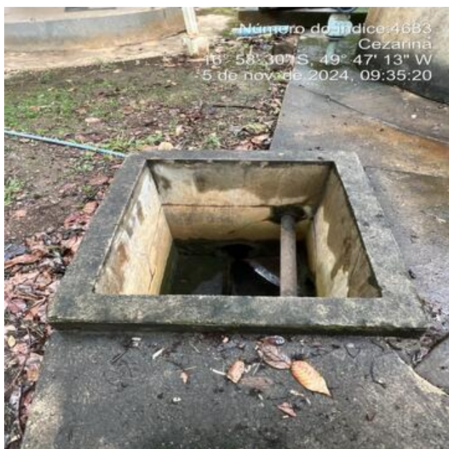
Foto 5 - ETA/Caixas de passagem sem tampa ou grade de proteção.
