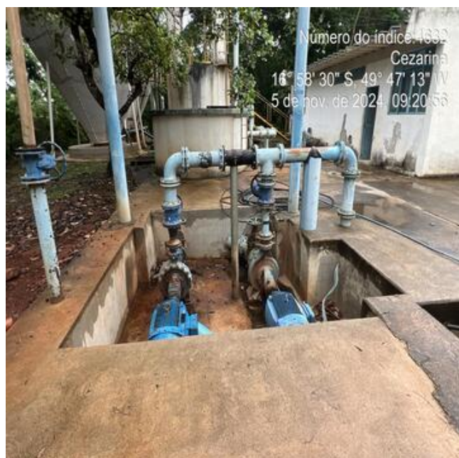
Foto 11 - ETA/EEAT com ausência de grade de proteção.
