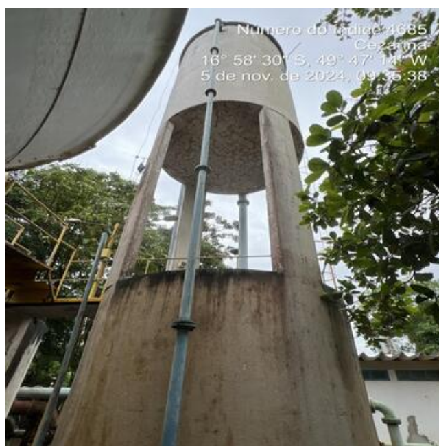
Foto 18 - ETA/REL 35 m³ concreto, lavagem de filtros com pintura desgastada.
