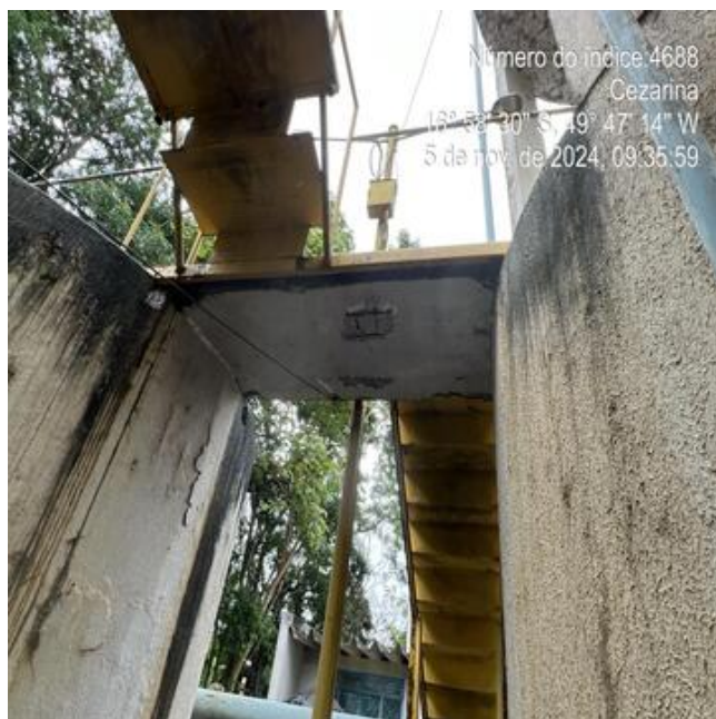
Foto 9 - ETA/Filtração perda de revestimento, ferragem exposta e pintura desgastada.
