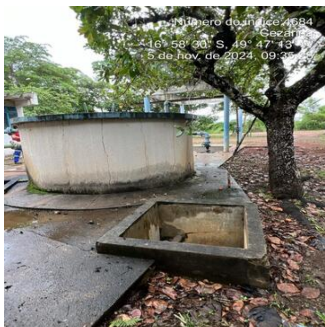
Foto 17 - ETA/RAP 15 m³ concreto, pintura desgastada e caixa de passagem sem tampa ou grade de proteção.
