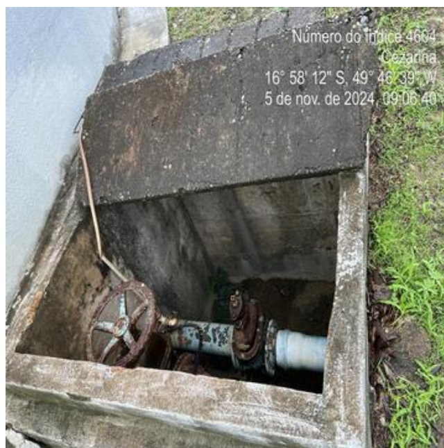
Foto 16 - Centro de Reserva Elza Amaral, caixas de passagem sem tampa ou grade de proteção.
