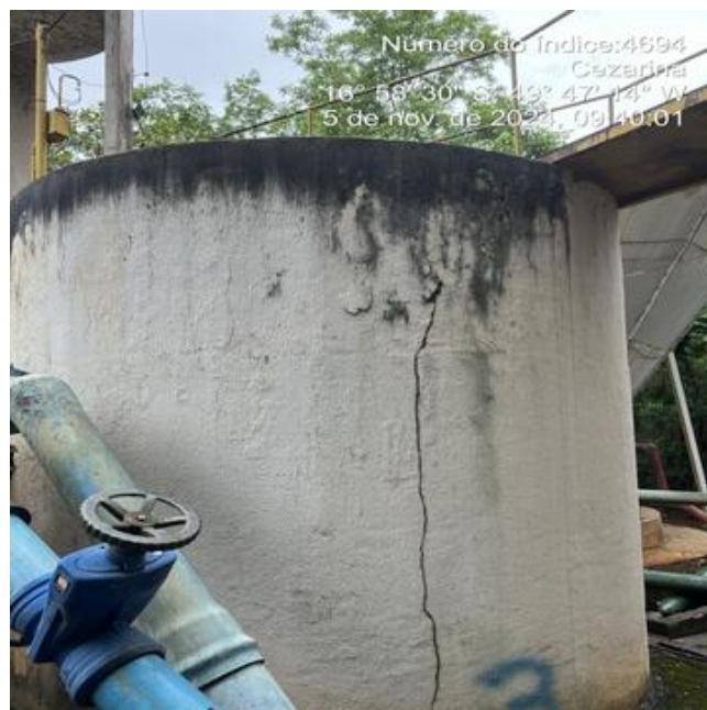
Foto 10 - ETA/Floco decantadores em mal estado de conservação, infiltrações e pintura desgastada.
