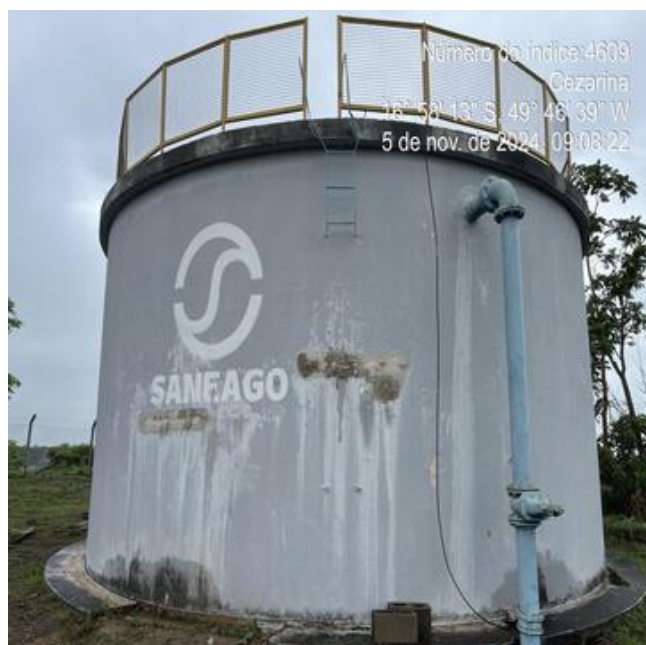
Foto 15 - Centro de Reserva Elza Amaral/RAP 200 m³ concreto II, com infiltração, eflorescência e pintura desgastada.
