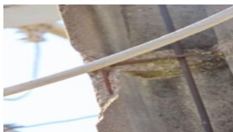
Foto 15.1 – SE MPO - Estrutura com ferragem exposta (ANTES)
