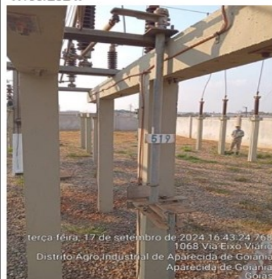
Foto 16.19 – SE CEP- Aterramento rompido (seccionadora 515). Corrigido em 18/09/2024.
