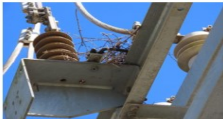
Foto 19.2 – SE MPO – Sujeira estrutura metálica setor 13, 8 KV (ANTES).
