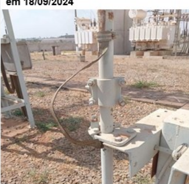
Foto 16.12 – SE CEP- Aterramento da concertina rompido. Corrigido em 18/09/2024.
