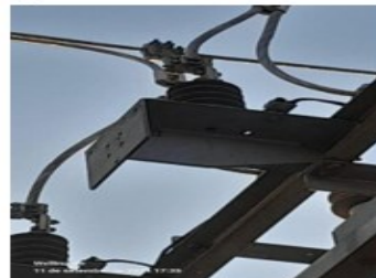
Foto 19.2 – SE MPO – Sujeira estrutura metálica setor 13, 8 KV (DEPOIS). Corrigido em 11/09/2024.
