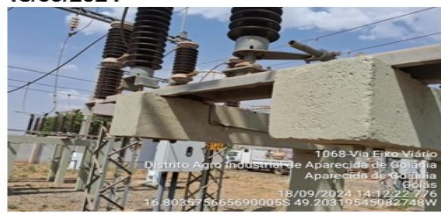
Foto 15.3 – SE CEP - Estrutura com ferragem exposta. Corrigido em 18/09/2024
