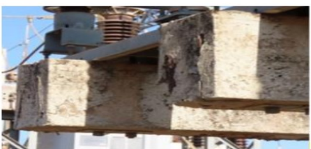
Foto 15.3 – SE CEP - Estrutura com ferragem exposta (ANTES).
