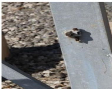
Foto 16.8 – Aterramento da cerca da SE rompido (antes).
