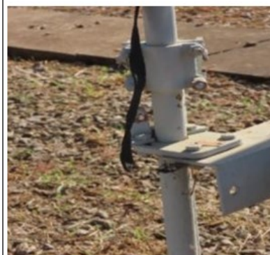
Foto 16.12 – SE CEP- Aterramento da concertina rompido (antes).
