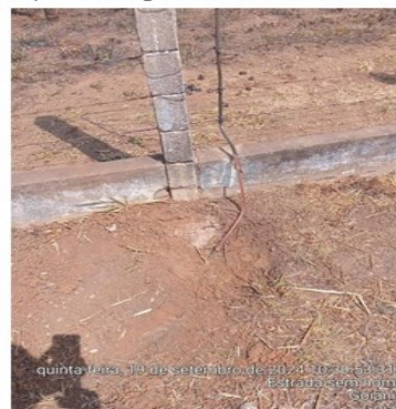
Foto 16.8 – Aterramento da cerca da SE rompido. Corrigido em 19/09/2024.
