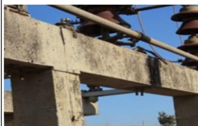
Foto 16.11 – SE CEP- Cordoalha da seccionadora rompido (antes).
