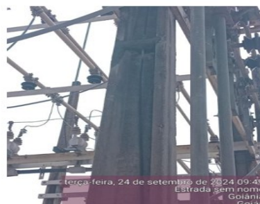
Foto 15.2 – SE MPO - Estrutura com ferragem exposta. Corrigido em 19/09/2024
