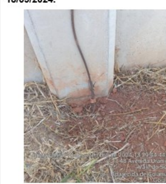
Foto 16.12 – SE CEP- Aterramento da concertina rompido. Corrigido em 18/09/2024.
