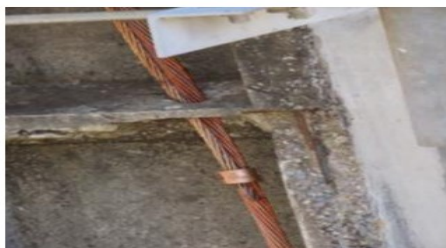
Foto 15.3 – SE CEP - Estrutura com ferragem exposta (ANTES).
