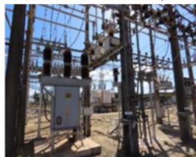
Foto 17.2 – SE MPO- Merejamento de óleo Transformador de Corrente 13,8 KV
