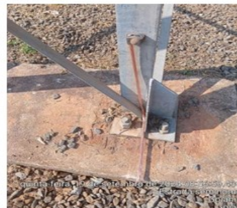
Foto 16.8 – Aterramento da cerca da SE rompido. Corrigido em 19/09/2024.
