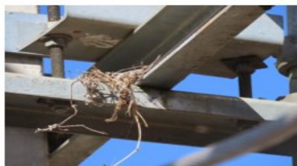
Foto 19.1 – SE MPO – Sujeira no barramento de 13,8 KV (ANTES).
