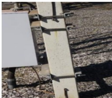
Foto 16.5 – MPO – Aterramento de seccionadora rompido (antes).
