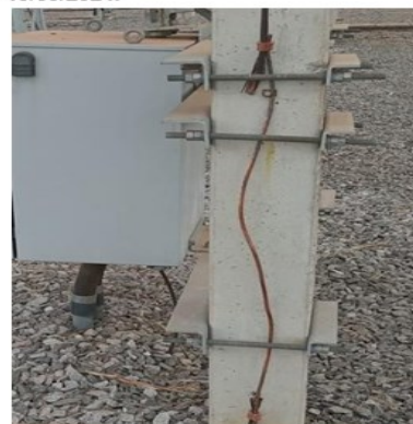
Foto 16.6 – SE MPO– Aterramento da caixa de comando da seccionadora rompido. Corrigido em 19/09/2024.
