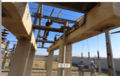
Foto 16.9 – SE CEP -Aterramento rompido (seccionadora 519) (antes).
