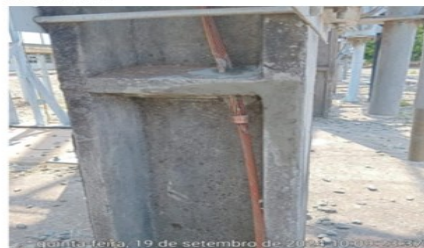
Foto 15.3 – SE CEP - Estrutura com ferragem exposta. Corrigido em 18/09/2024
