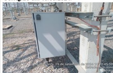
Foto 16.6 – SE MPO– Aterramento da caixa de comando da seccionadora rompido. Corrigido em 19/09/2024.
