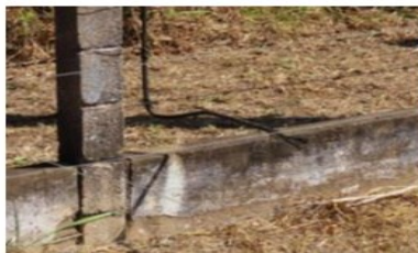
Foto 16.8 – Aterramento da cerca da SE rompido (antes).
