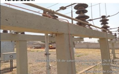
Foto 16.11 – SE CEP- Cordoalha da seccionadora rompido (depois). Corrigido em 18/09/2024
