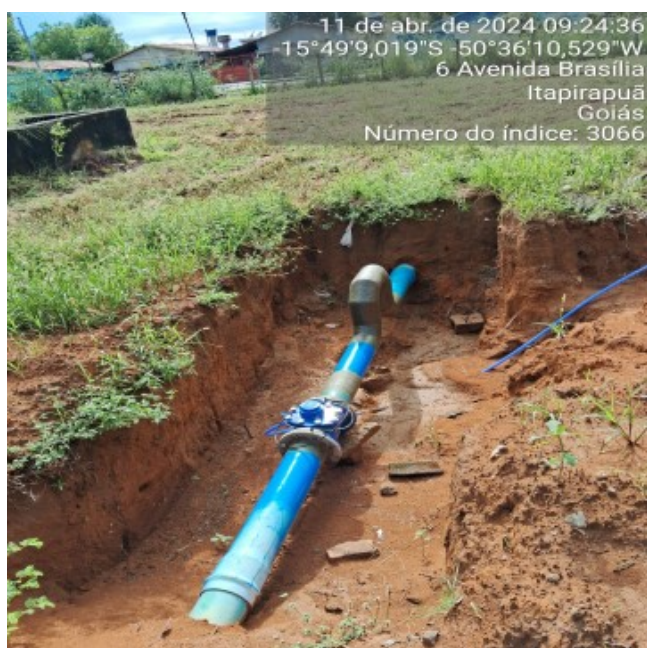
Foto 1 - REL/Escritório com escavação não finalizada.
