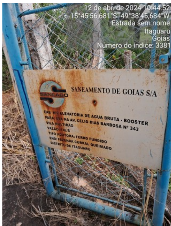
Foto 1 - EEAB/Intermediária com placa de identificação deteriorada.
