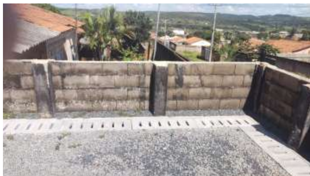
Foto 8 - Calha de concreto construída ao longo do muro de arrimo.
