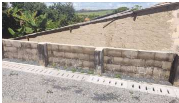
Foto 4 - Vista da face de montante do muro de arrimo.
