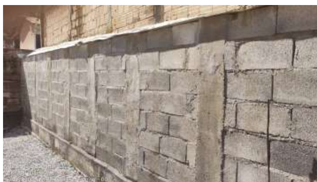
Foto 15 - Muro de arrimo localizado aos fundos do Centro de Reservação.
