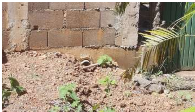
Foto 12 - Saídas da canalização de drenagem.
