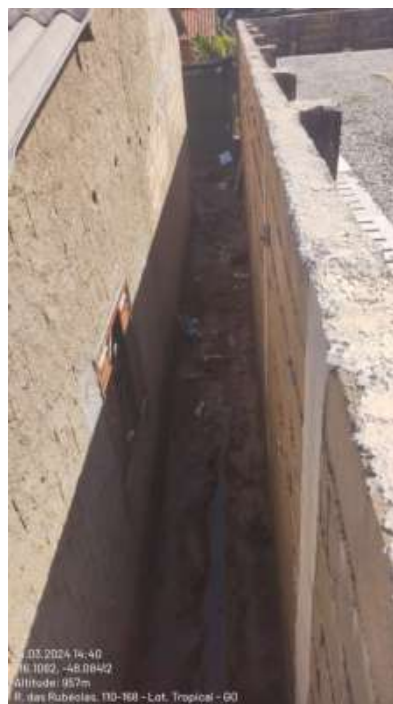
Foto 14 - Vista entre o muro de arrimo e a moradia limítrofe.
