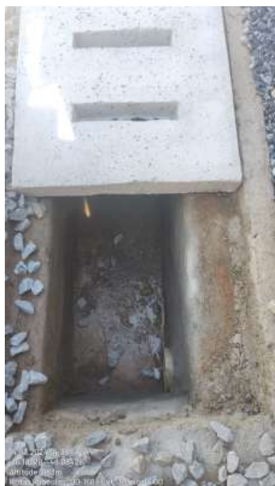
Foto 9 - Detalhe da calha de concreto e dreno de água superficial.
