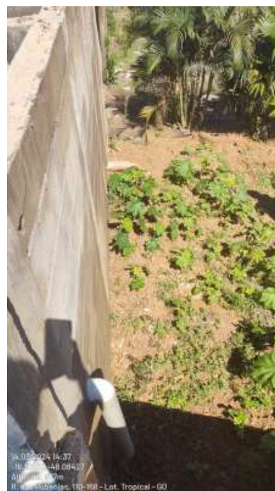
Foto 10 - Saída de água do dreno junto ao passeio público.
