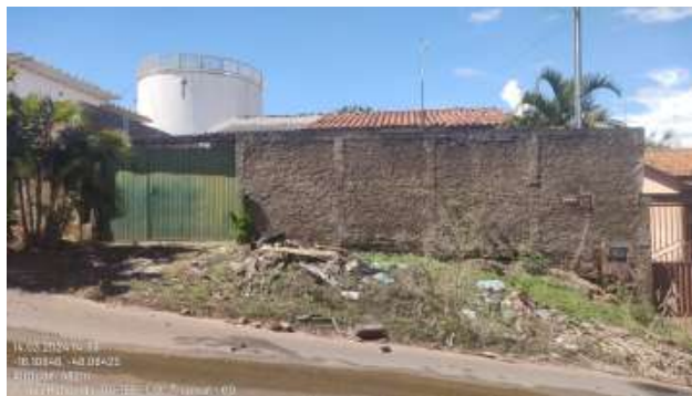
Foto 2 - Vista da moradia vizinha ao CR.
