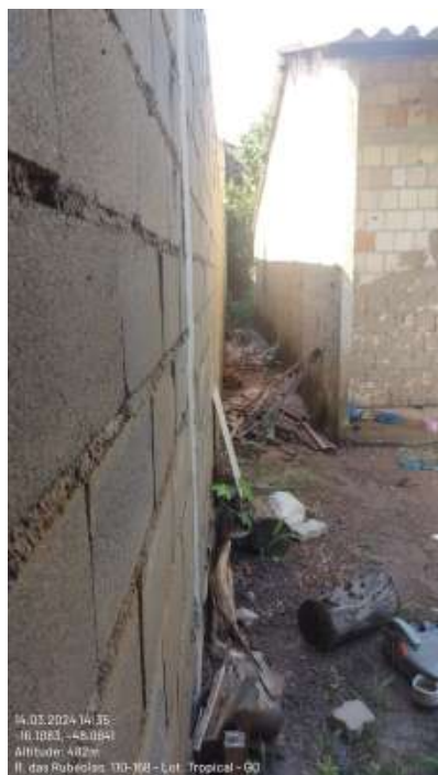
Foto 13 - Visão da "face de jusante" do muro de arrimo (foto obtida de fora do lote).
