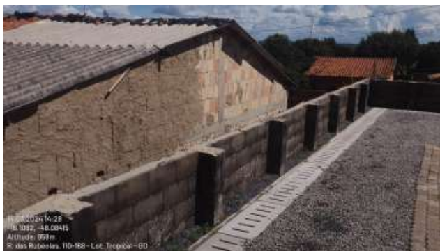
Foto 5 - Vista da face de montante do muro de arrimo e da superfície revestida com brita, calha de concreto e filtro de areia grossa.
