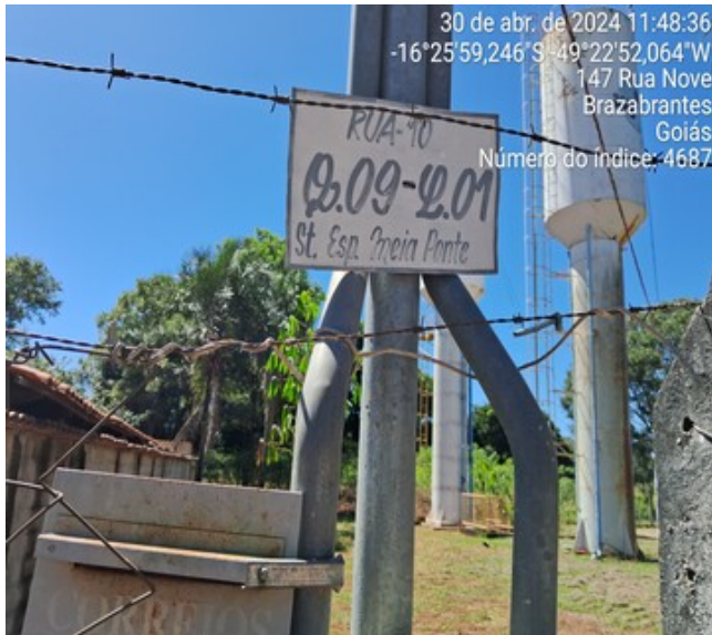
Foto 1 - EEAT/CR Esplanada sem identificação.
