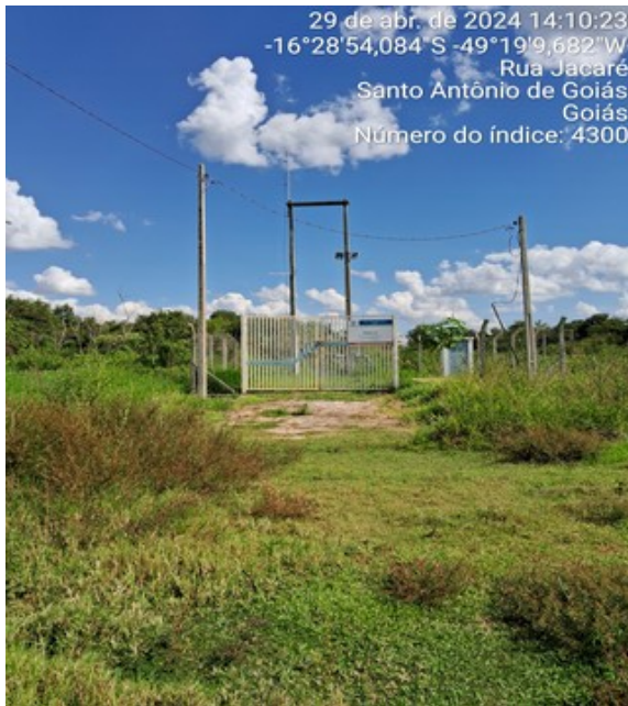
Foto 5 - Condições inadequadas de acesso ao Poço 11 e presença de mato alto.
