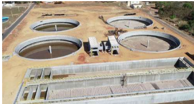
Figura 21. Estação de Tratamento de Esgoto (ETE) em Goiânia
