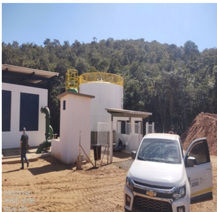
Foto 9 - Captação/EEAB Ribeirão Santa Rosa à montante da captação sistema Santa Rosa, em fase de conclusão.
